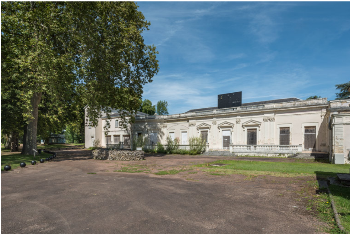
Façade, vue depuis le sud-ouest.
