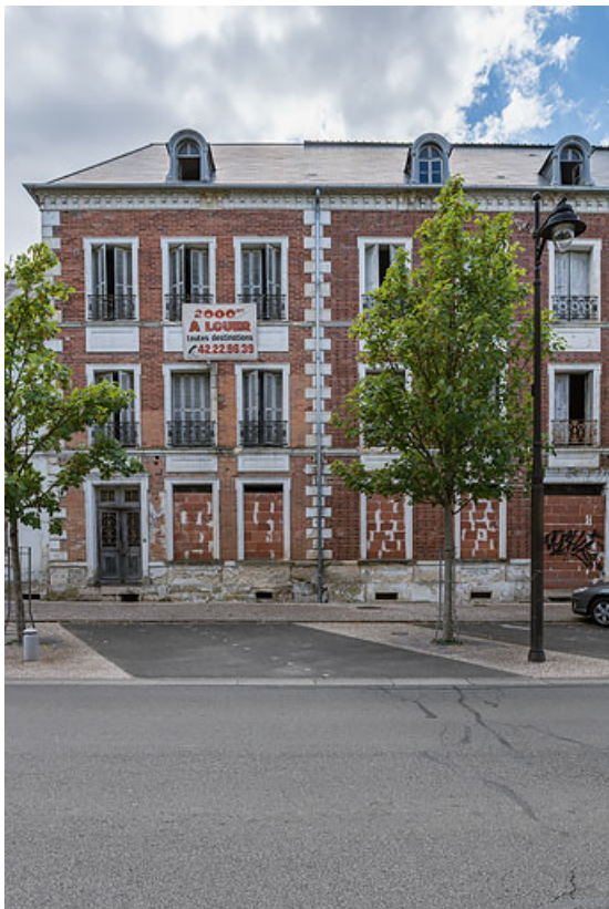
Façade de l'extension de Jules Guimard. 58, Pougues-les-Eaux, 34 avenue de Paris
