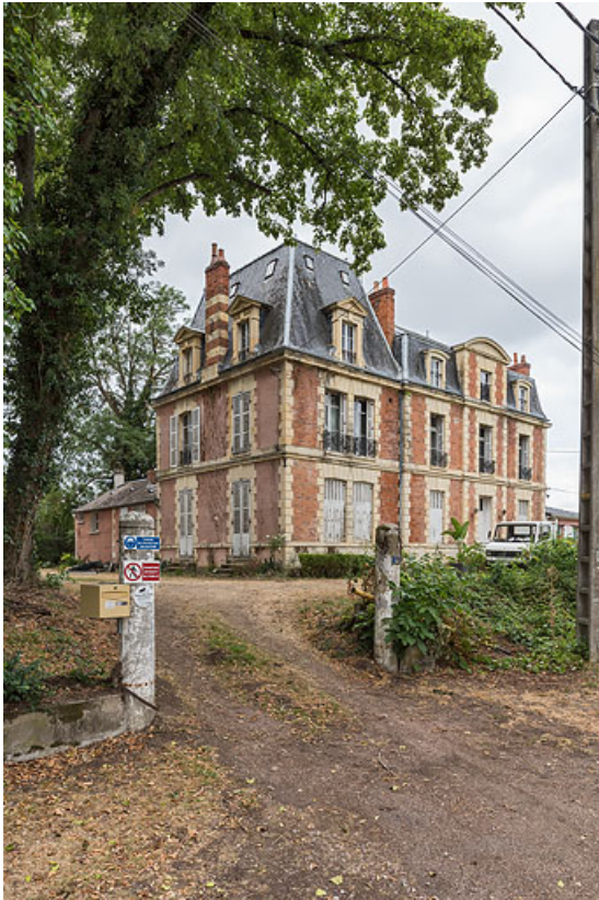
Vue d'ensemble depuis l'accès sur l'avenue de Paris.
