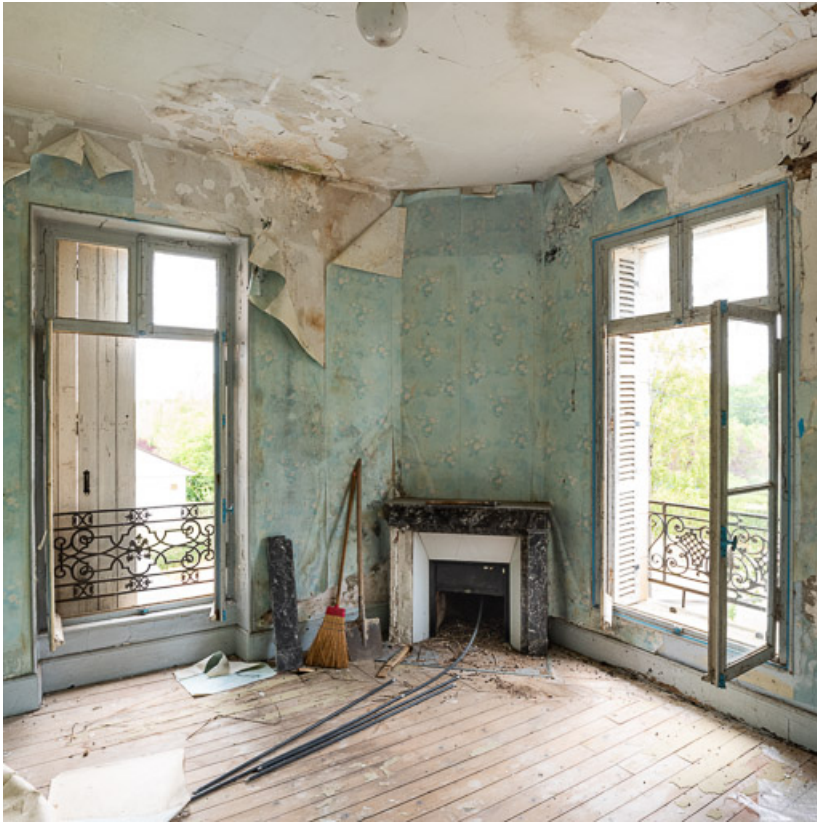
Chambre au premier étage avec deux fenêtres et une cheminée dans l'angle. 58, Pougues-les-Eaux, 6A avenue de Paris
