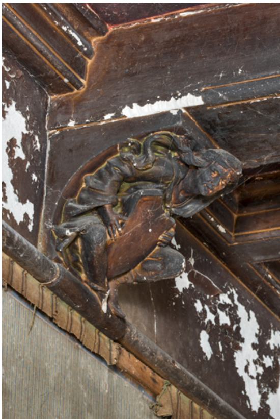
Pièce principale, corbeau : personnage portant un écu.
