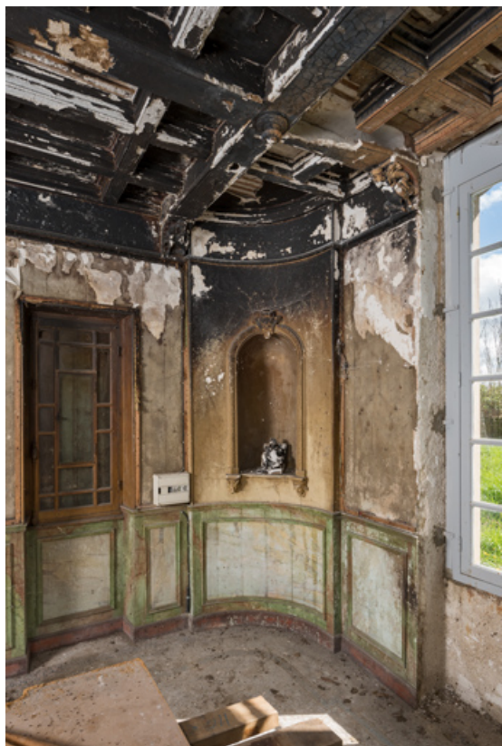
Pièce principale, niche dans l'angle.
