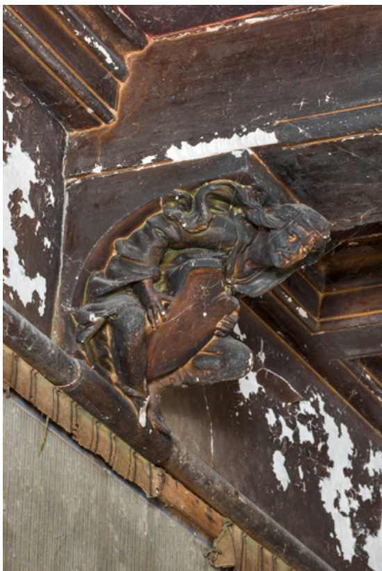
Pièce principale, corbeau : personnage portant un écu.
