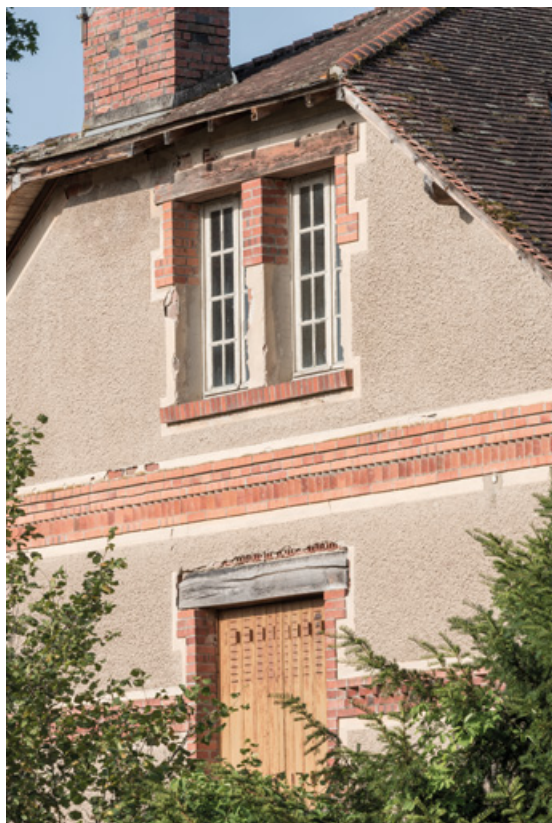
Mur pignon occidental, détail des baies jumelées de l'étage de comble.
