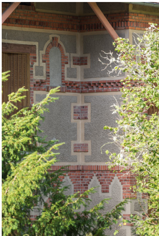
Façade principale, ressaut et décor de brique.
