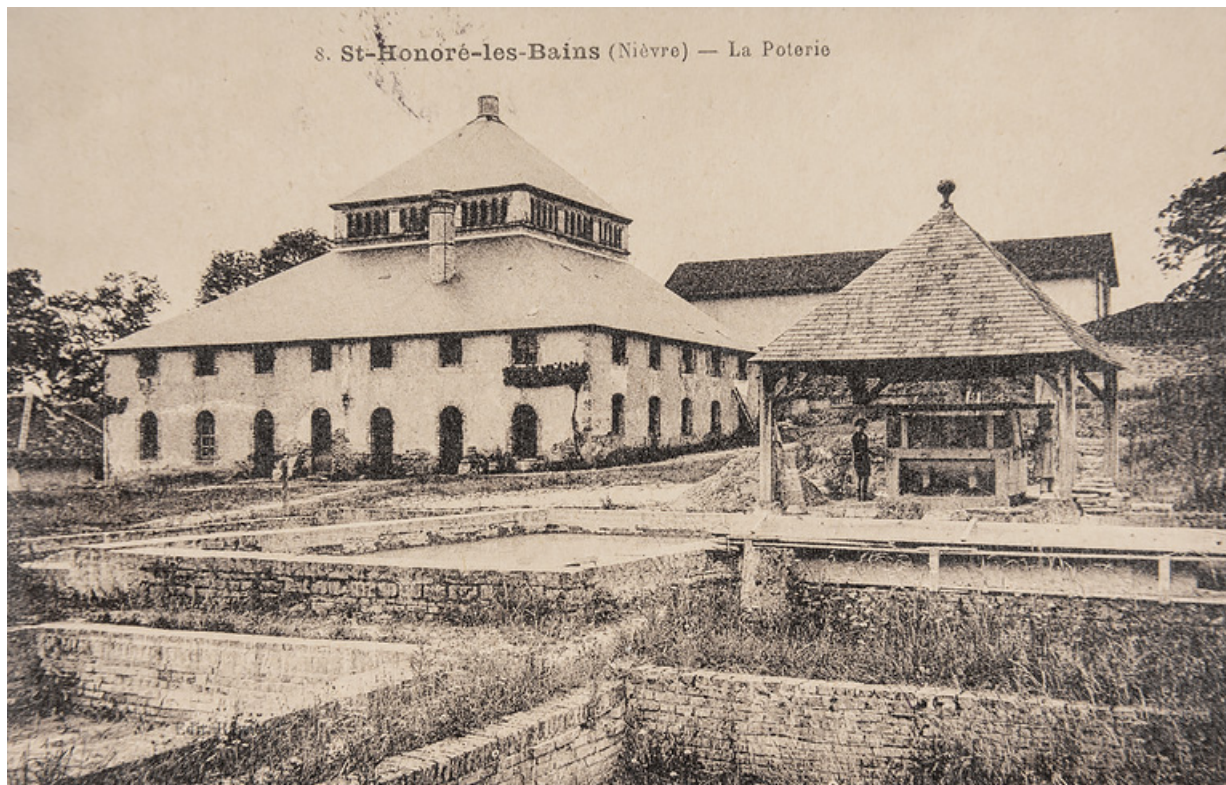
Vue depuis le nord, avec le malaxeur (à droite).
