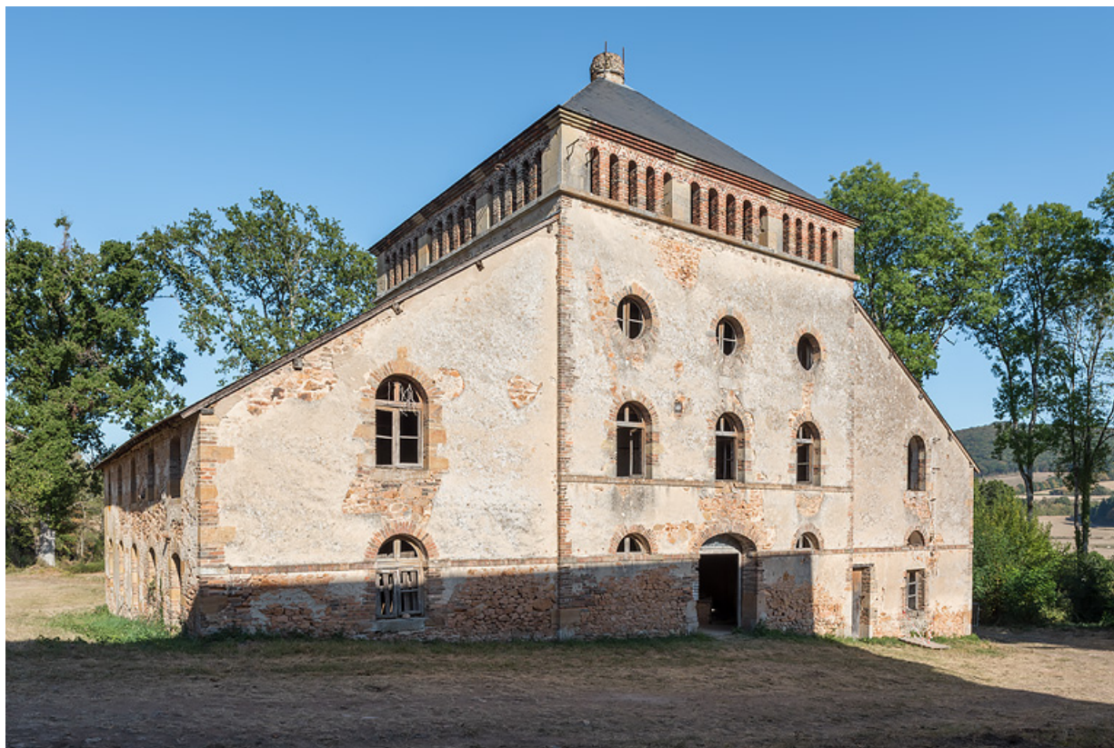
Vue depuis l'ouest, état actuel.
