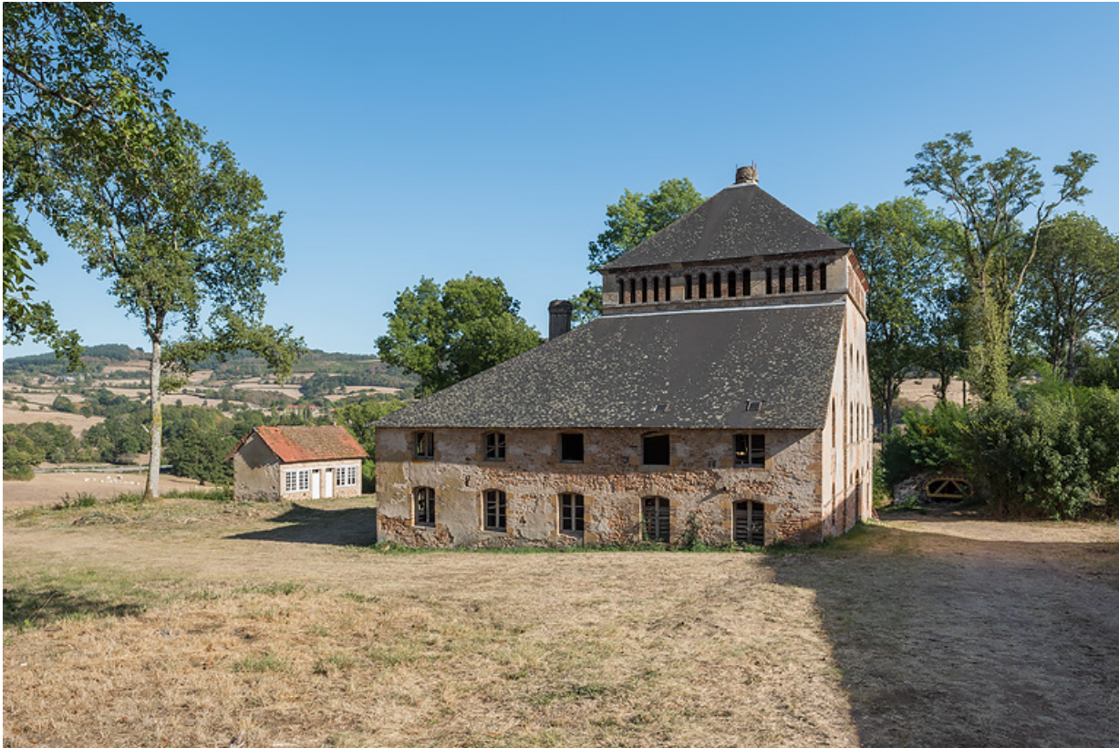
Vue depuis le nord-ouest, état actuel.
