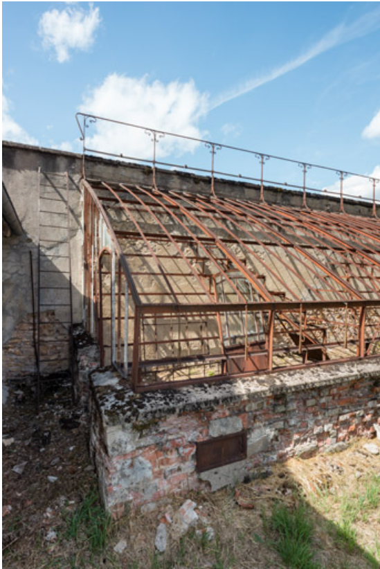
Détail de la structure métallique construite sur un muret en brique et adossée à un mur en calcaire. 58, Saint-Honoré-les-Bains, 8 avenue de Rémilly
