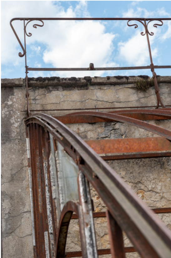
Détail de la structure métallique et du garde-corps de la galerie du mur.
