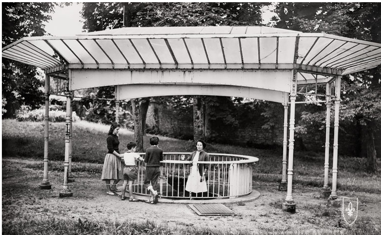
Buvette sur le site du Ponteau, premier état d'abandon (années 1970). 58, Pougues-les-Eaux avenue de Paris
