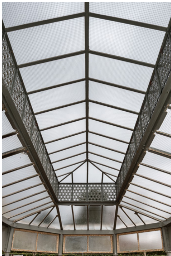
Buvette "reconstruite" à son emplacement actuel, vue intérieure.
