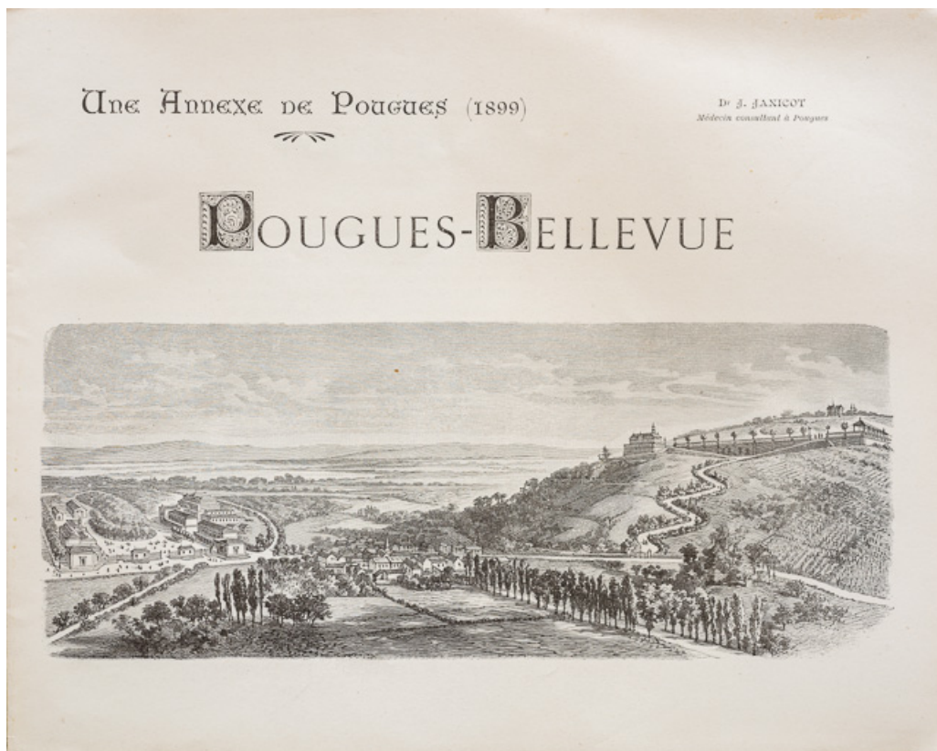
Vue du domaine de Pougues-Bellevue, avec le bourg et le quartier thermal. 58, Pougues-les-Eaux avenue de Paris, lieudit : Bellevue
