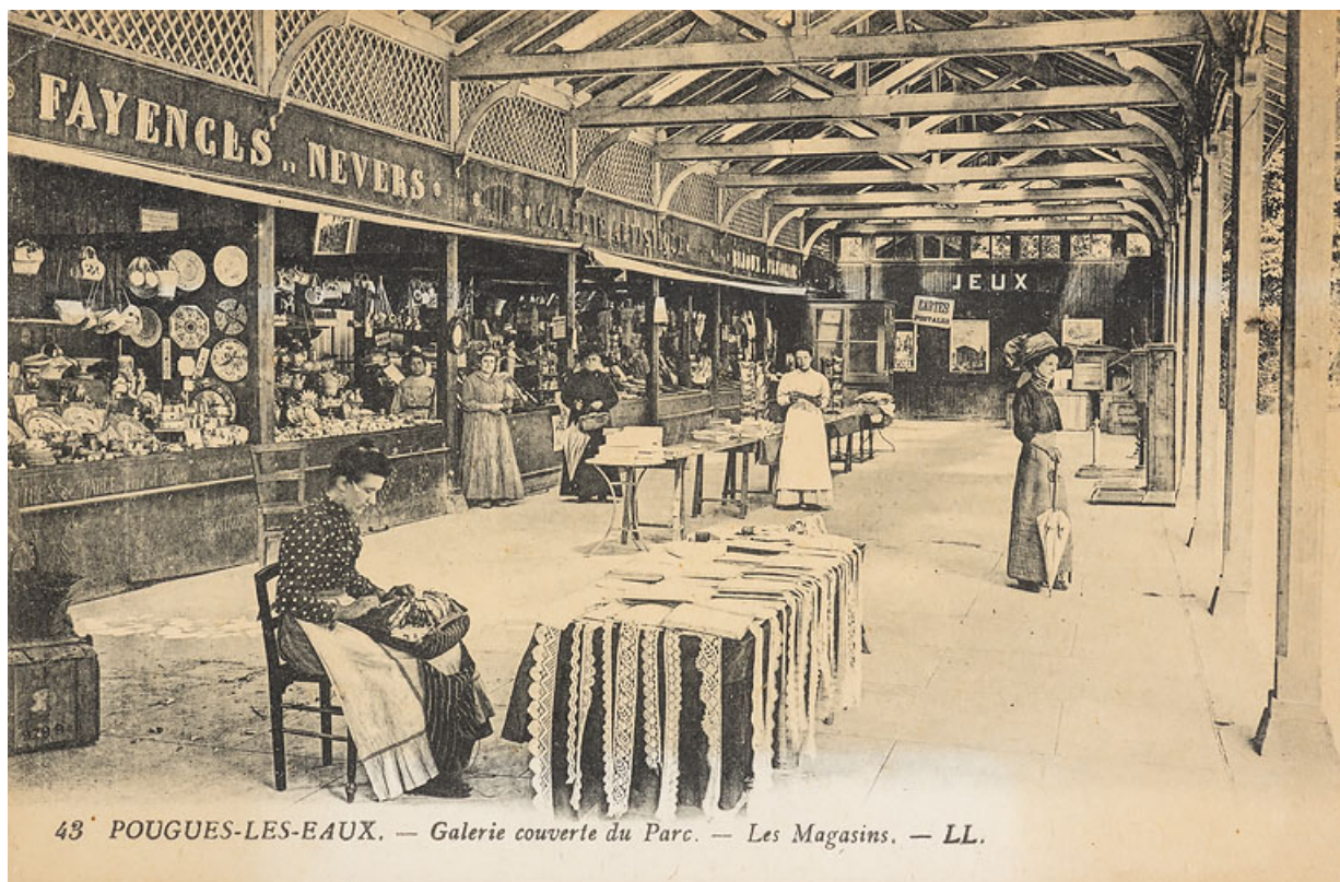
Vue des boutiques donnant sur l'allée couverte.
