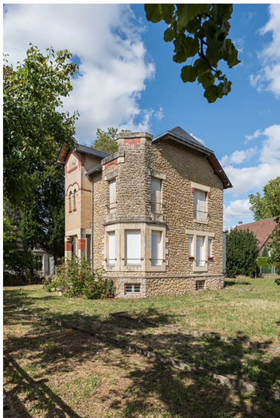
Vue depuis le sud-ouest.
