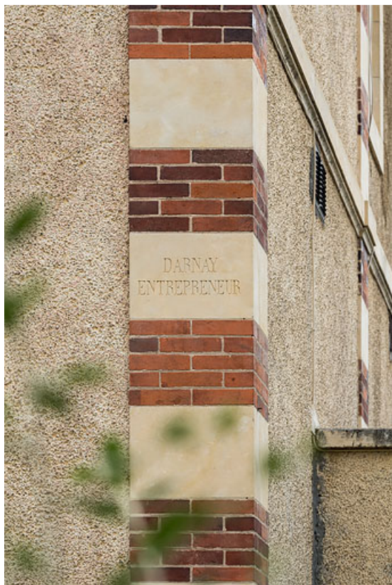
Ressaut droit de l'avant-corps de la façade principale, signature : "DARNAY ENTREPRENEUR". 58, Pougues-les-Eaux, 6 avenue de Conti
