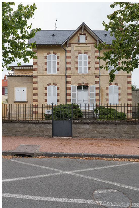
Vue de face, depuis l'avenue du Casino.
