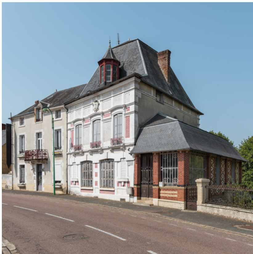
Façade sur l'actuelle avenue du Général d'Espeuilles. 58, Saint-Honoré-les-Bains, 47 avenue du Général d'Espeuilles
