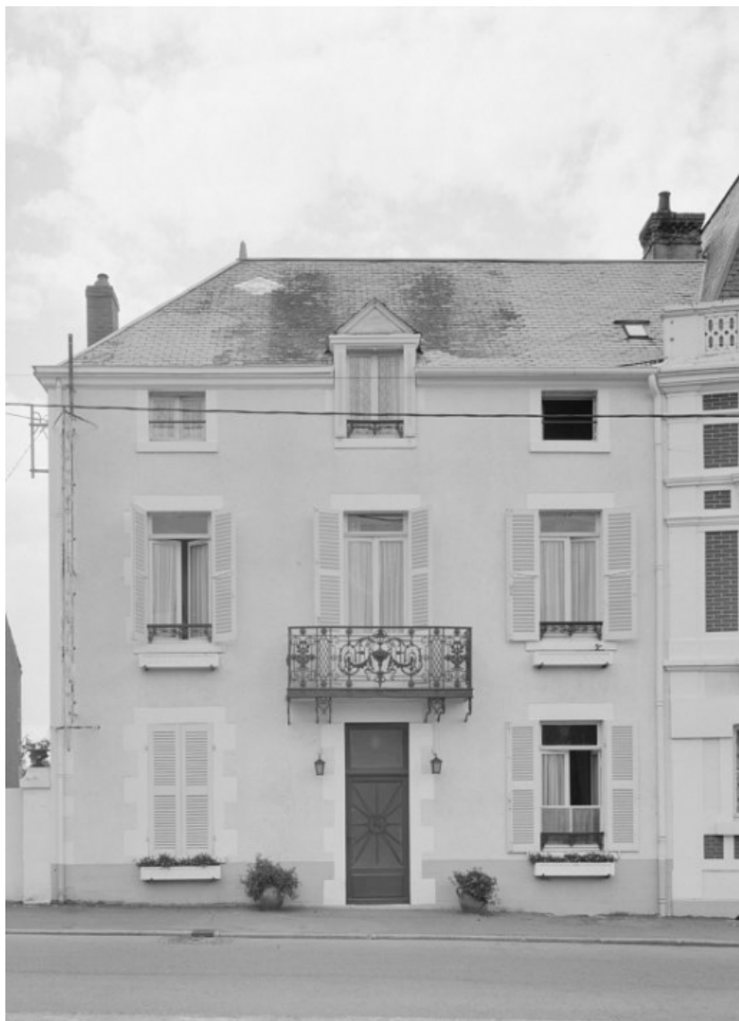
Façade sur l'actuelle avenue du Général d'Espeuilles, partie sud, en 1978. 58, Saint-Honoré-les-Bains, 47 avenue du Général d'Espeuilles
