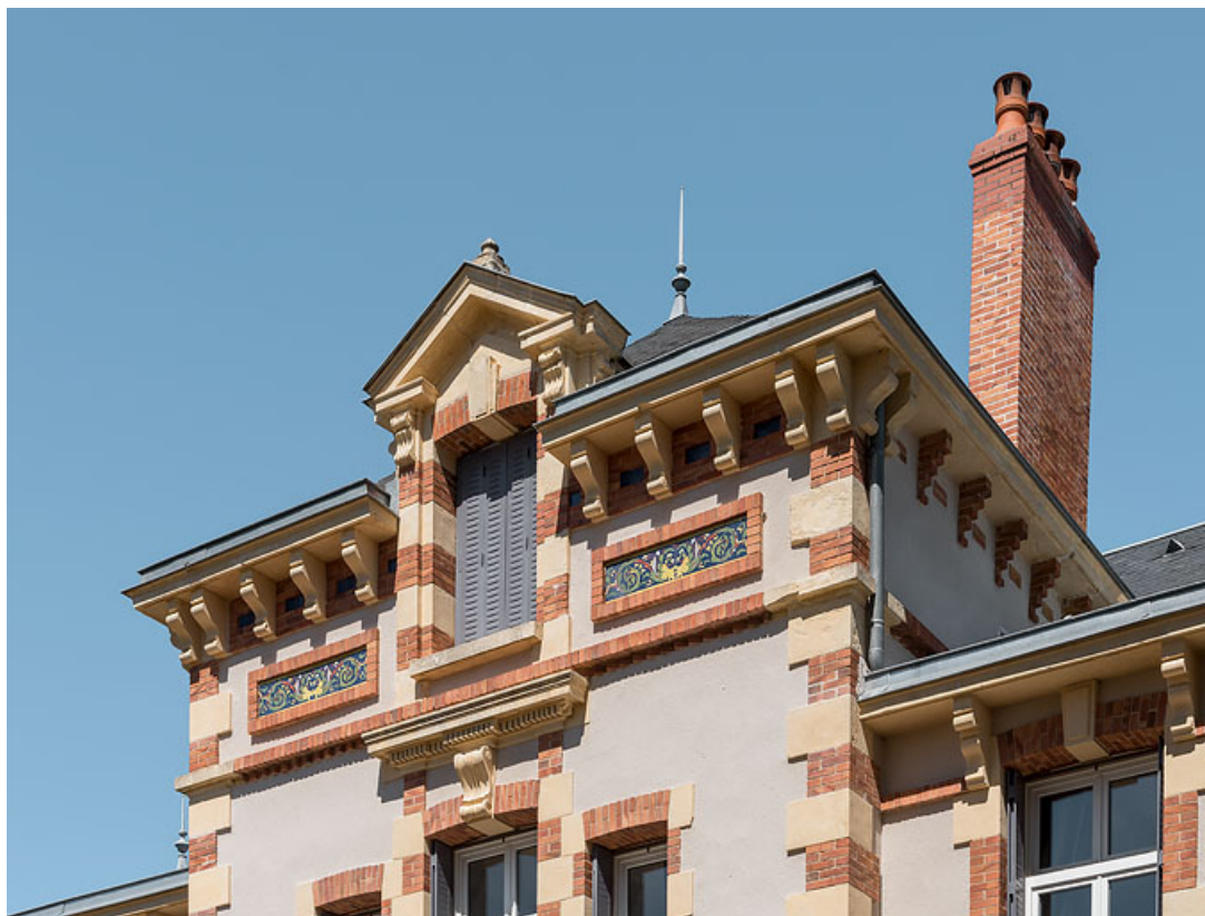
Avant-corps central de la façade principale, détail.
