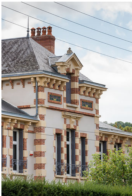
Avant-corps central de la façade principale, détail.
