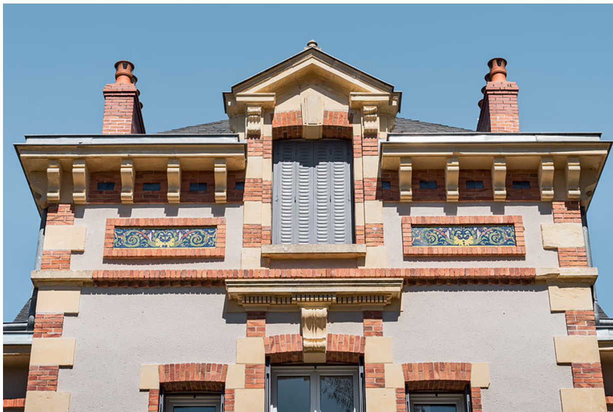
Avant-corps central de la façade principale, détail.
