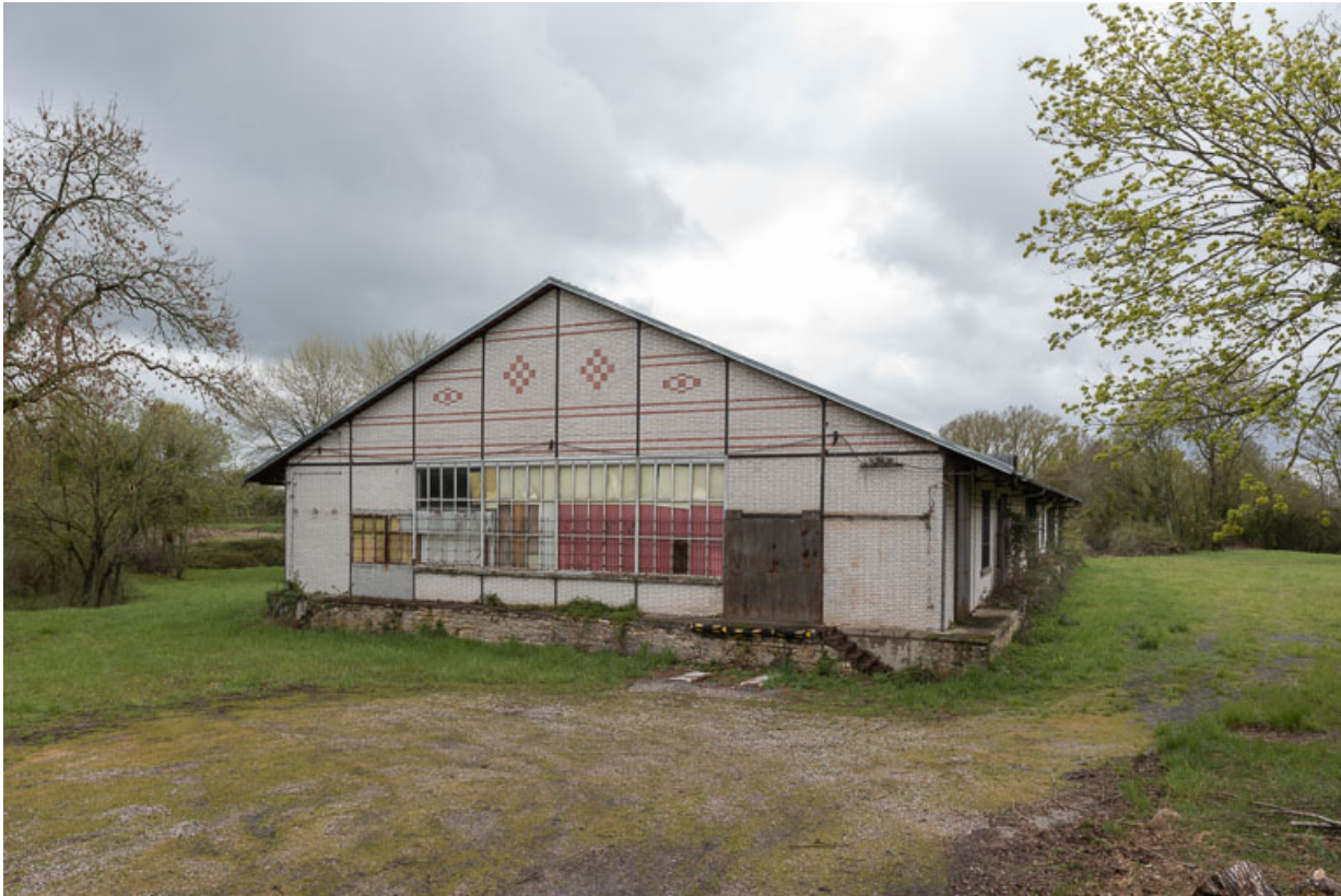
Bâtiment de l'embouteillage construit en 1928, mur pignon est et ancien quai de chargement nord. 58, Pougues-les-Eaux rue des Sources, lieudit : Le Ponteau
