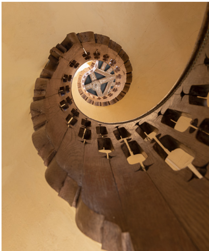
Escalier en vis, vue depuis le palier inférieur.
