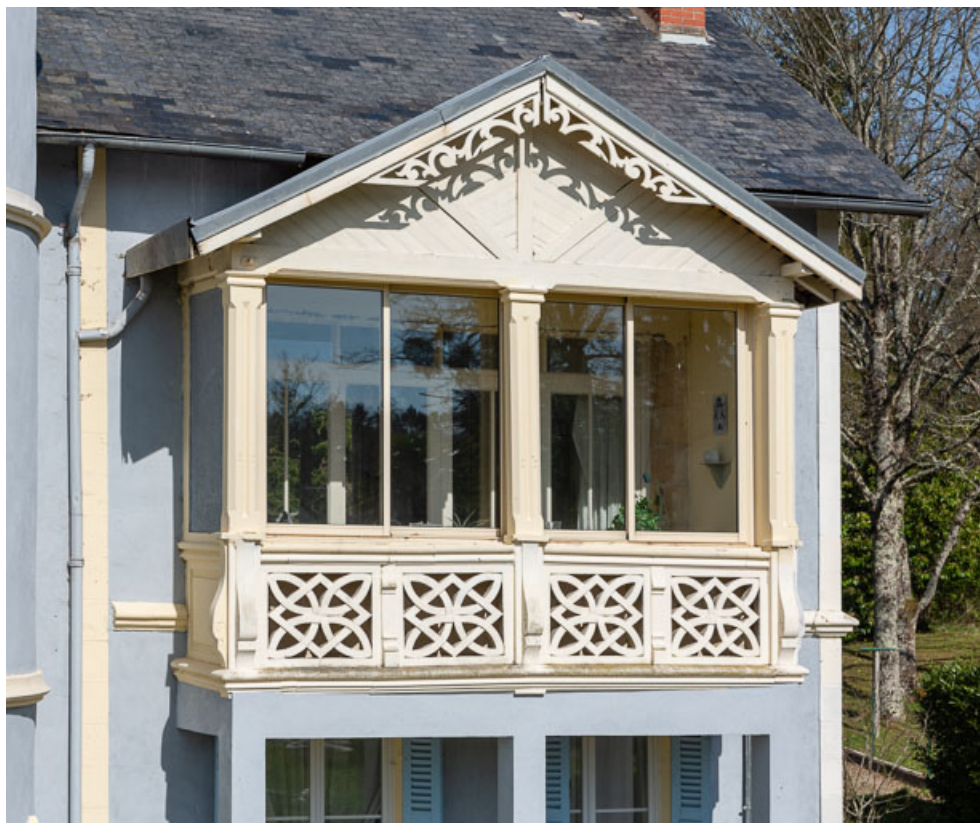
Façade sud-est, oriel.
