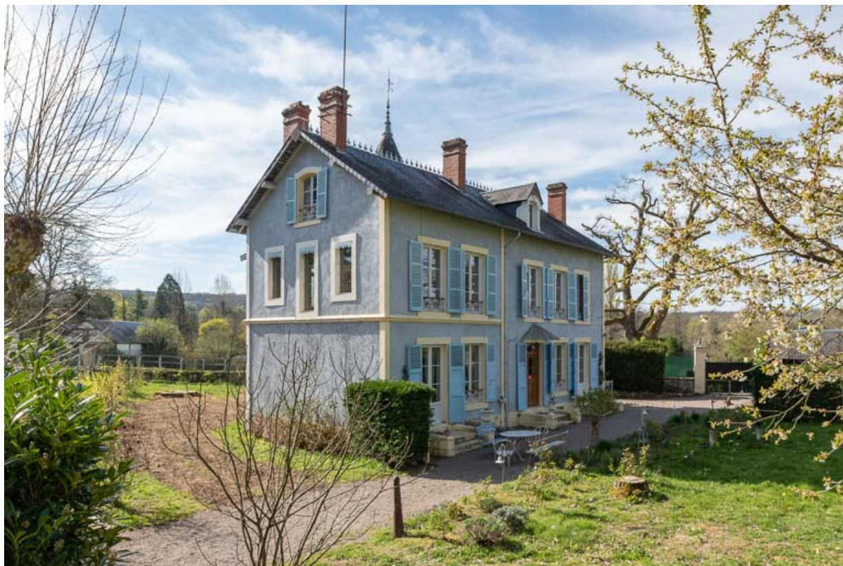
Façade nord-ouest et mur pignon nord-est.
