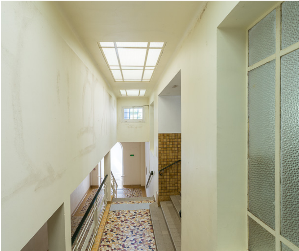
Passage du couloir (à gauche) dans l'établissement thermal.
