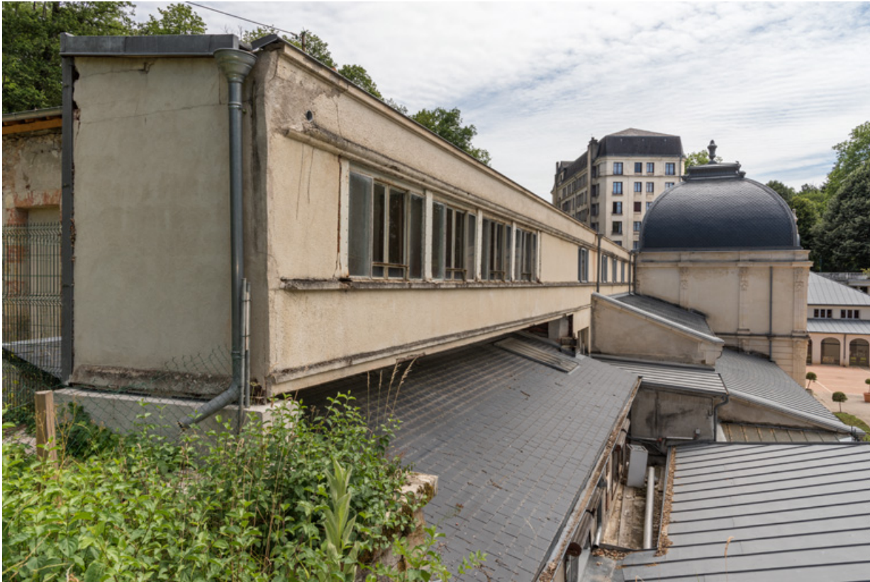
Vue extérieure depuis la terrasse du casino (détruit) en 2019. 58, Saint-Honoré-les-Bains avenue du Docteur Segard
