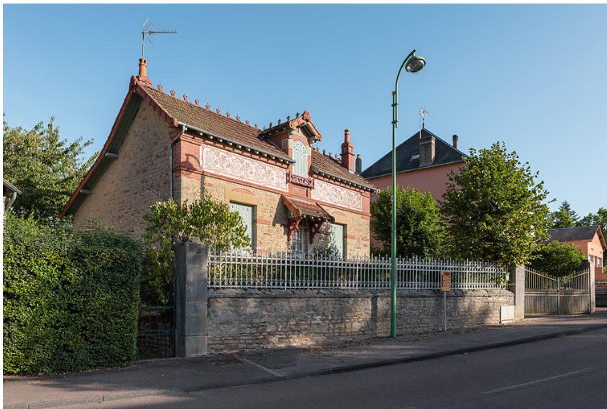
Élévation sur l'avenue Eugène Collin, vue depuis le sud.
