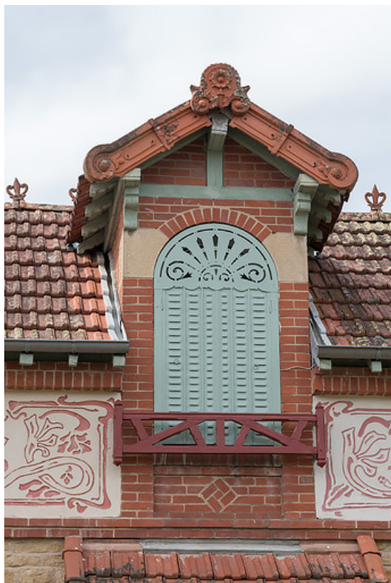
Lucarne à fenêtre pendante dotée d'un tympan métallique ajouré et d'un balconet en bois.
