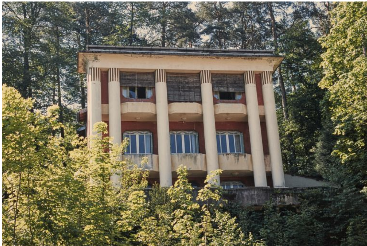
Façade nord, vue de face.
