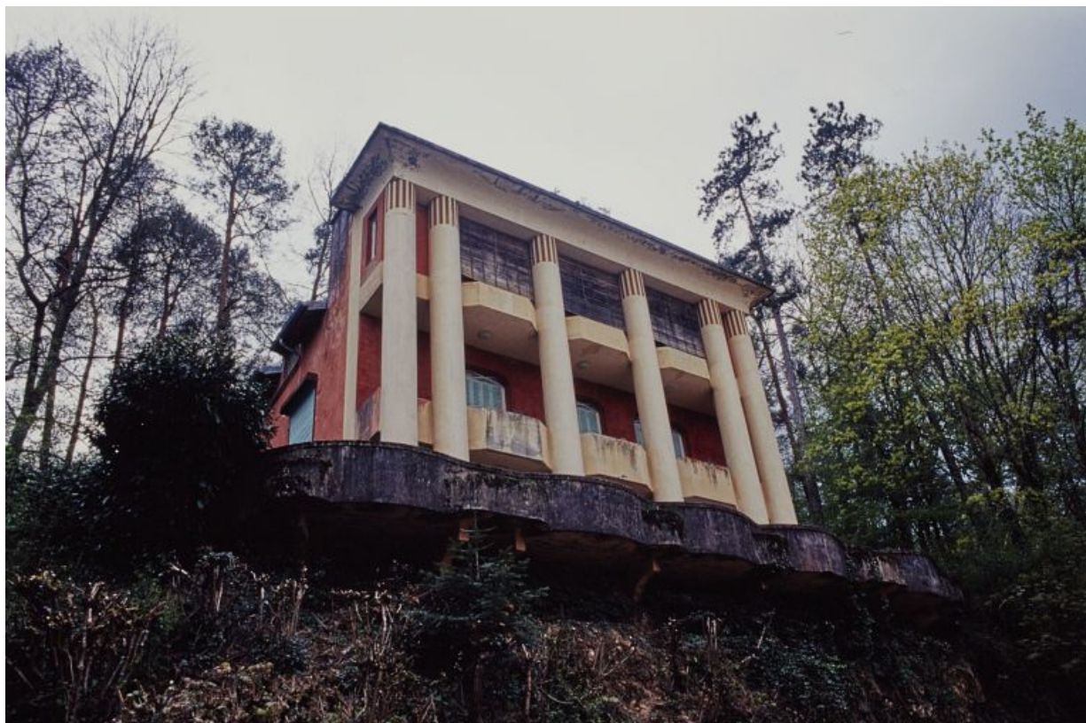
Façade nord, vue en contre-plongée.
