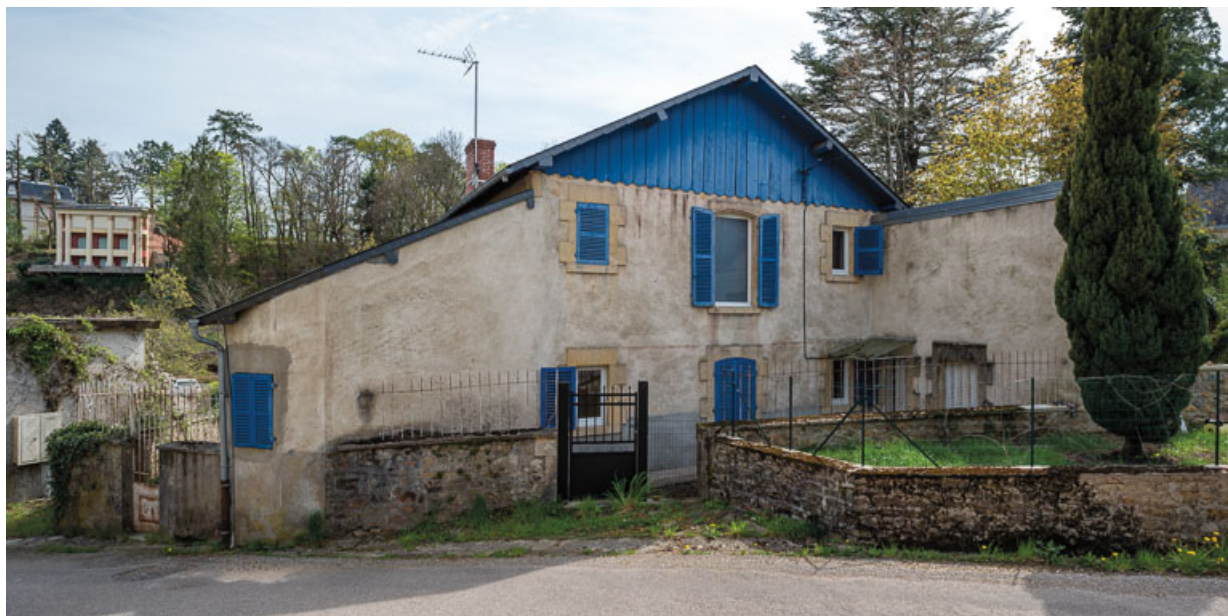
Élévation sur la rue de la Chaume, vue depuis le nord avec la Villa Marinette à l'arrière-plan. 58, Saint-Honoré-les-Bains, 6 avenue Jean Mermoz
