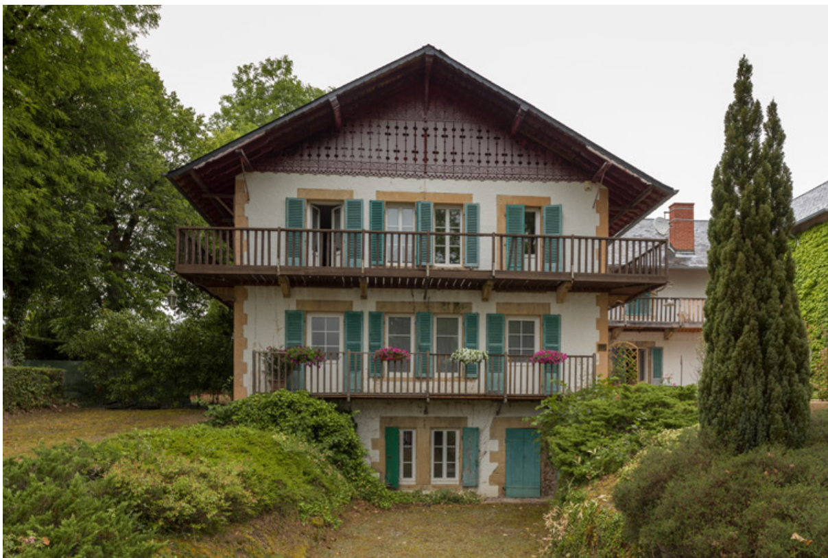
Façade du corps principal, vue de face.
