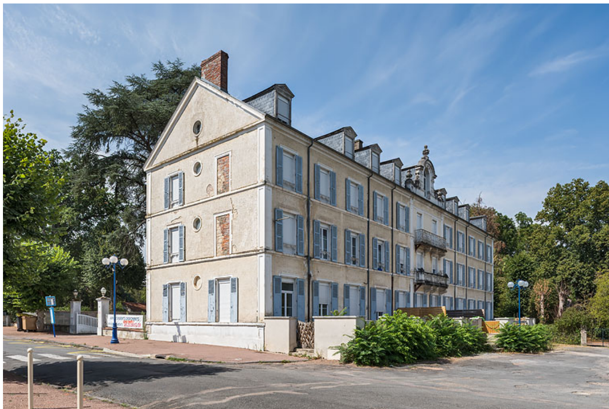
Façade nord du corps principal, vue en 2020.
