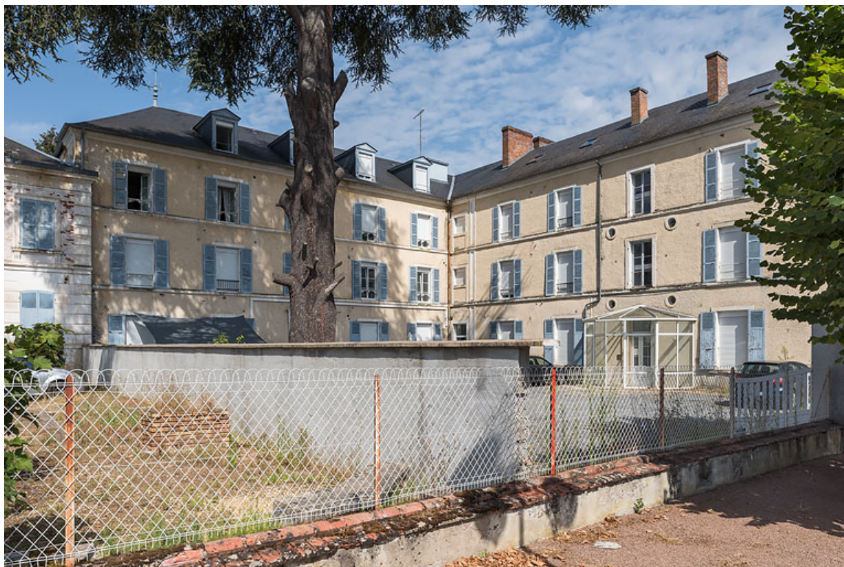
Façade sud du corps principal et façade est de l'aile en retour, vue en 2020. 58, Pougues-les-Eaux, 17 avenue de Conti
