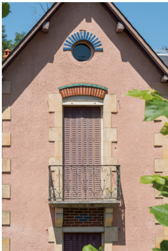
Mur-pignon, détail des ouvertures, vue de face.
