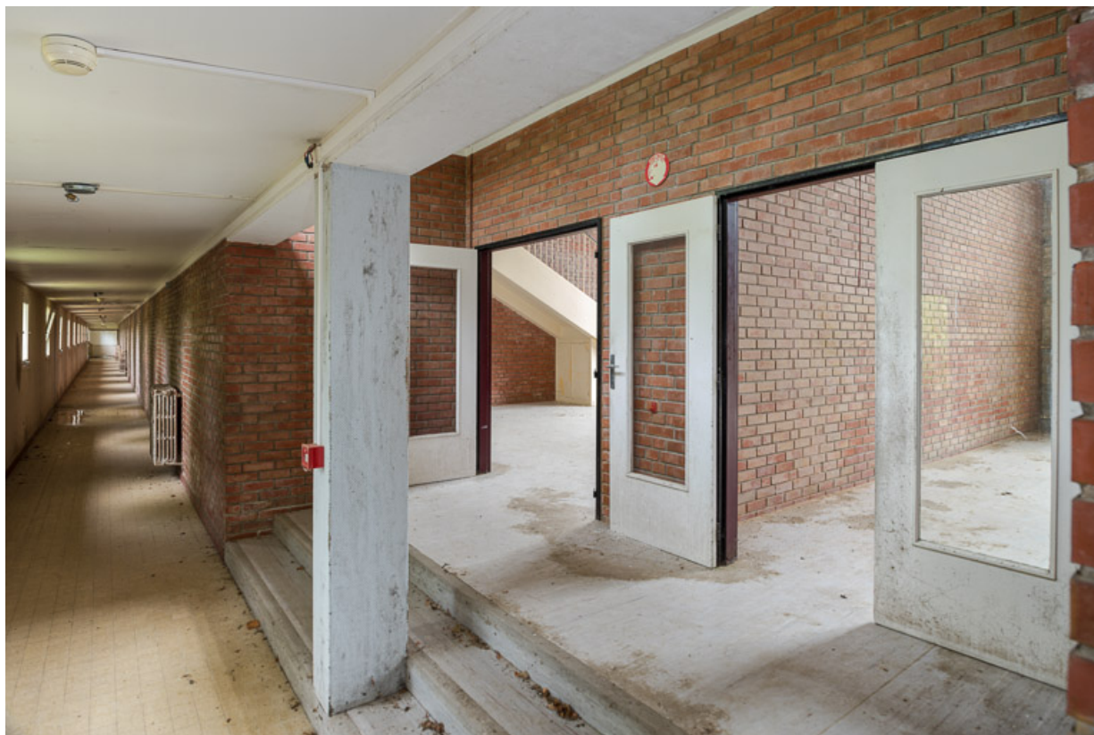
Couloir nord de l'aile Bellevue, vue en direction de l'est, et accès aux salles de jeux. 58, Saint-Honoré-les-Bains, 20 avenue Jean Mermoz
