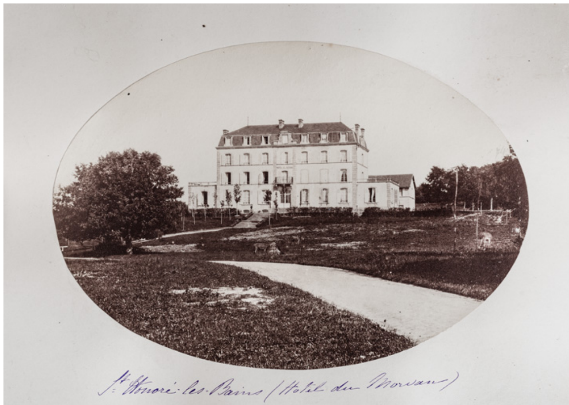
Façade sur le parc avant la construction des pavillons latéraux.
