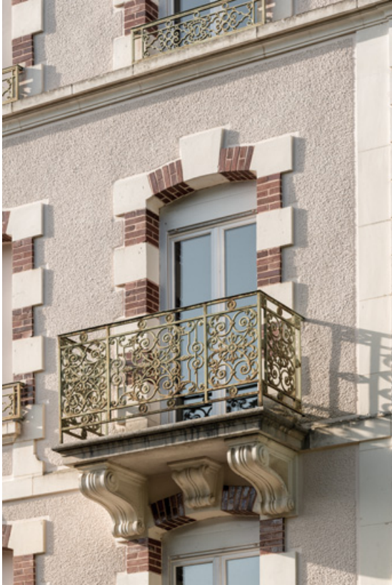
Pavillon occidental, balcon et garde-corps, vue de trois-quarts.
