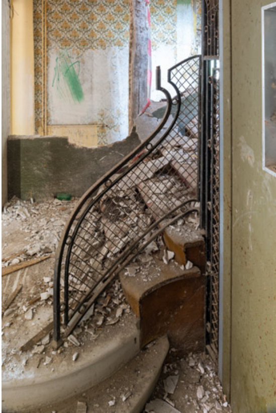
Escalier ouest, détail, rampe d'appui.
