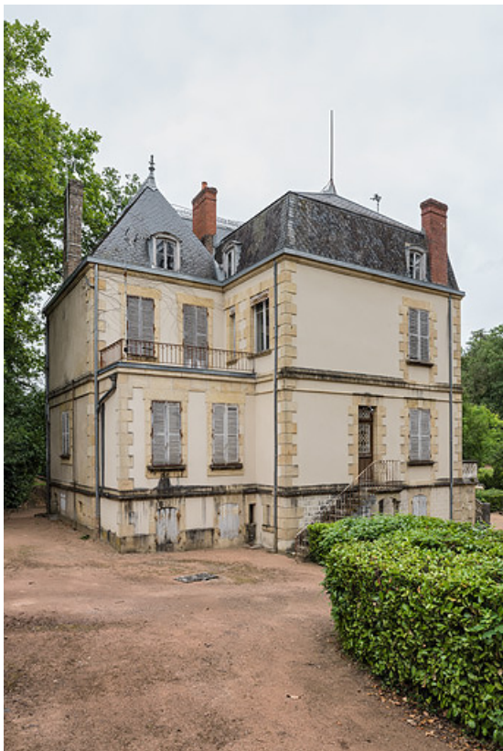
Élévation sud-ouest, vue depuis l'ouest.
