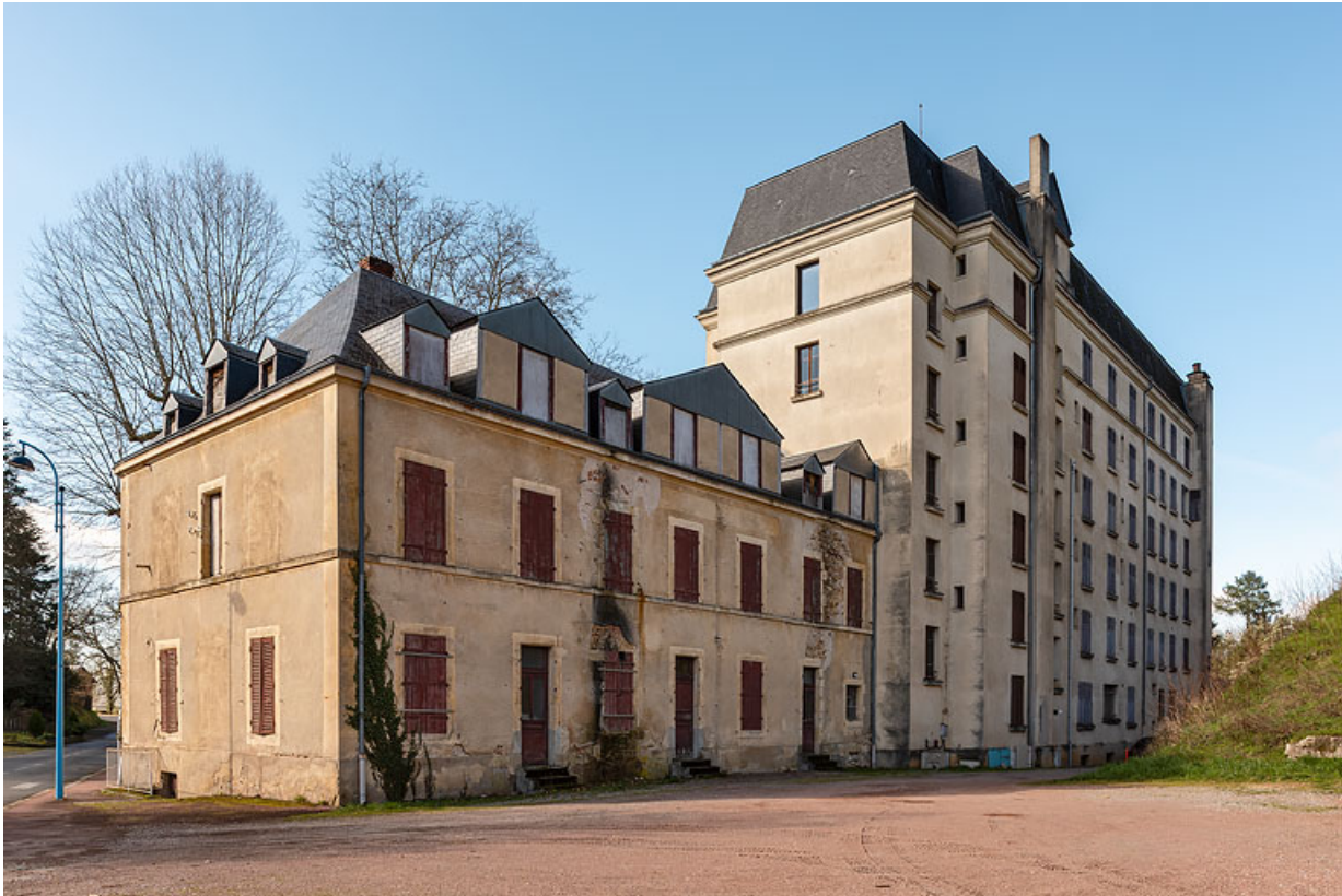
Façade postérieure, vue depuis la rue, avec l'Hôtel des Bains (à gauche).
