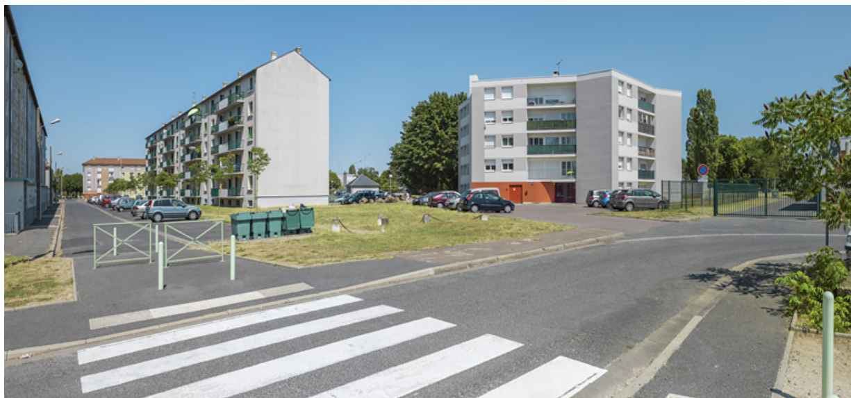
Bâtiment E, SIDEN et X depuis la place Pierre et Marie Curie. 58, Cosne-Cours-sur-Loire, 6 place Pierre et Marie Curie
