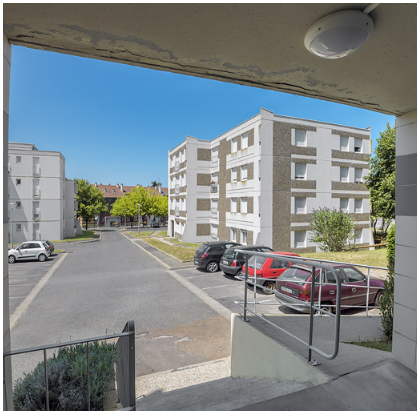
Vue sur le bâtiment 26 depuis le porche du bâtiment 27.
