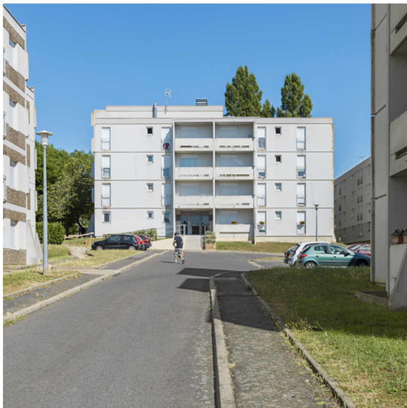
Bâtiment 27, façade antérieure ouest.
