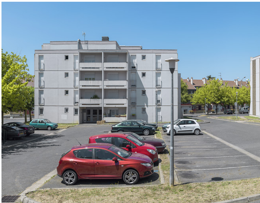
Bâtiment 25, façade antérieure est.
