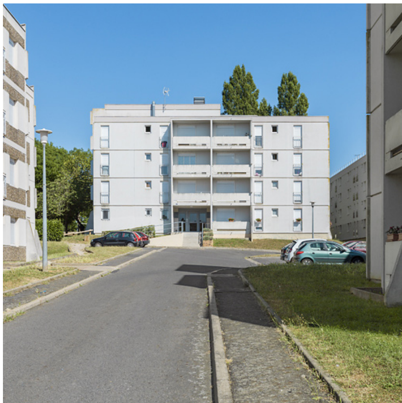
Bâtiment 27, façade antérieure ouest.
