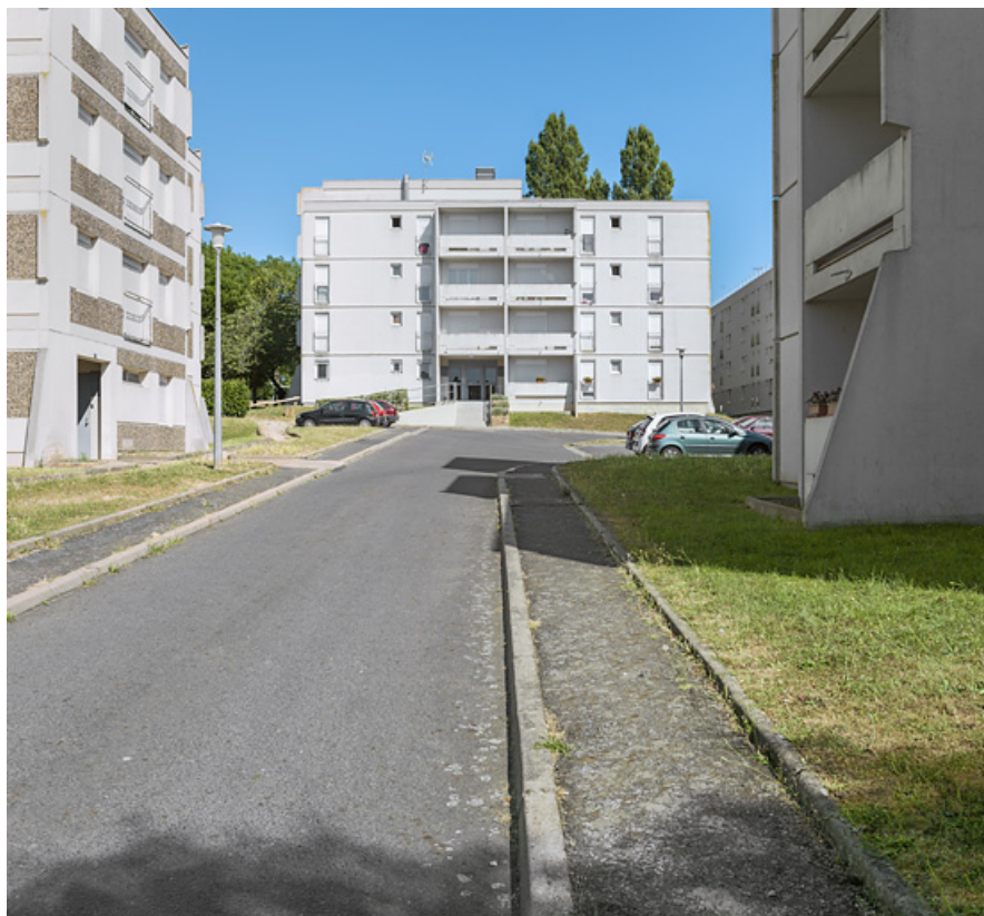
Bâtiment 27, façade antérieure ouest.
