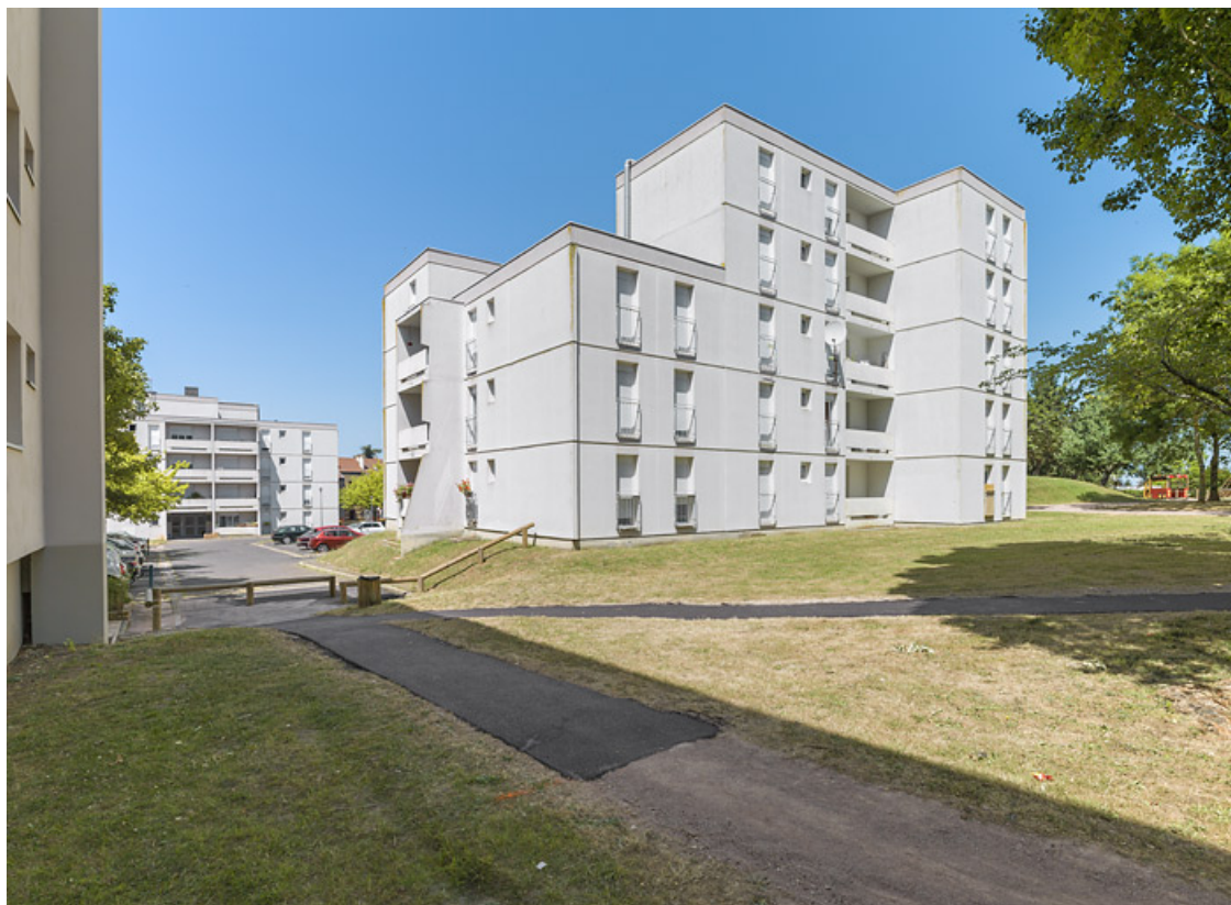
Bâtiment 27, façade latérale sud et façade postérieure est. 58, Cosne-Cours-sur-Loire rue Gay Lussac
