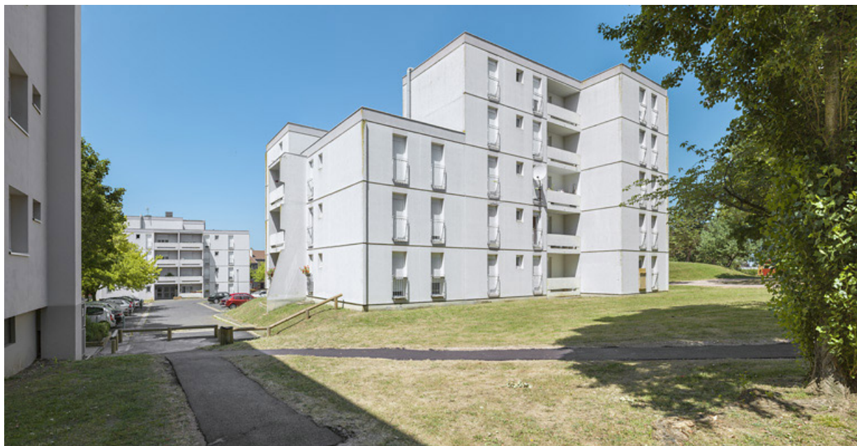
Bâtiment 27, façade latérale sud et façade postérieure est. 58, Cosne-Cours-sur-Loire rue Gay Lussac
