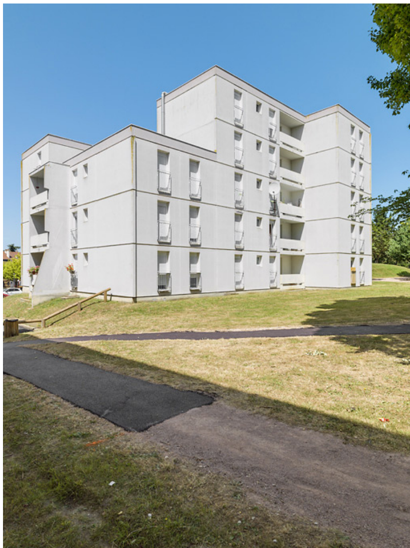
Bâtiment 27, façade latérale sud et façade postérieure est. 58, Cosne-Cours-sur-Loire rue Gay Lussac
