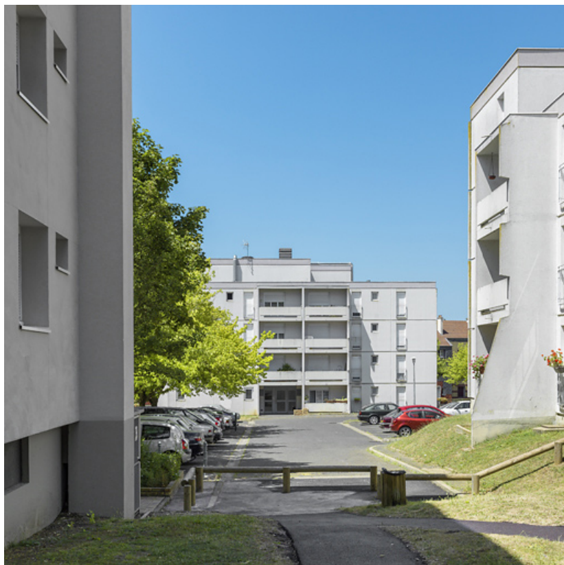
Bâtiment 27, façade antérieure.
