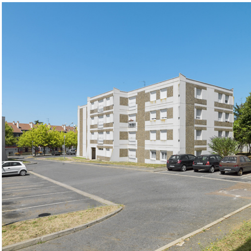
Bâtiment 26, façades antérieure et latérale. 58, Cosne-Cours-sur-Loire rue Gay Lussac
