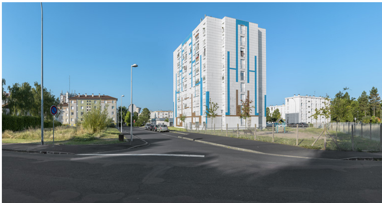
Tour Schweitzer, façade postérieur est et façade latérale nord.
