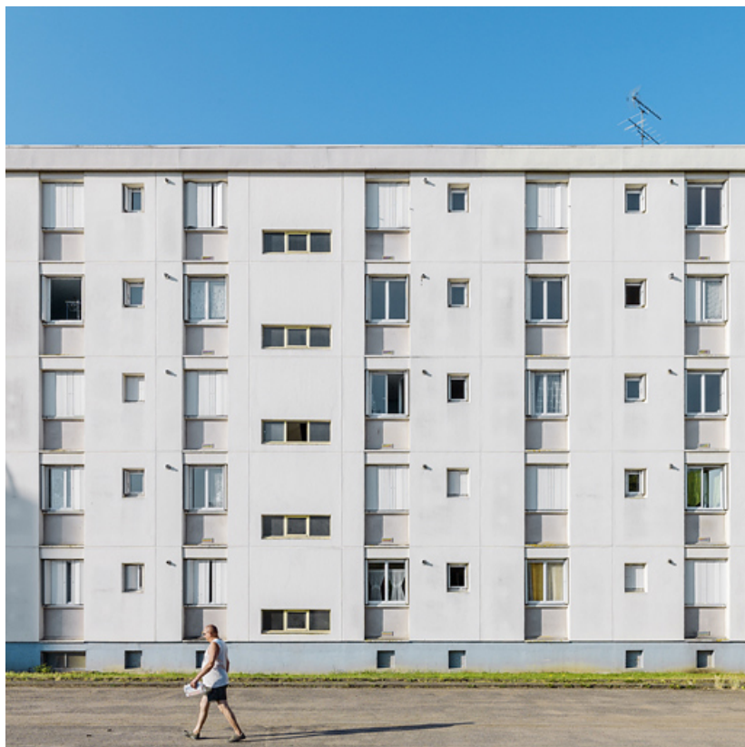
Bâtiment B-1, façade postérieure nord.
