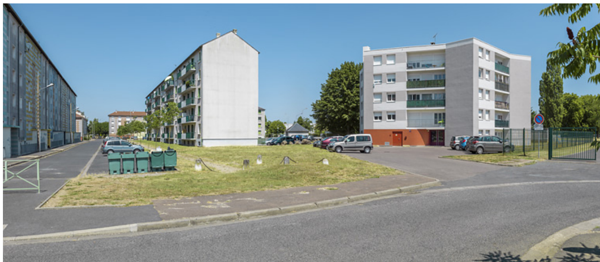
Bâtiment E, SIDEN et X depuis la place Pierre et Marie Curie.
