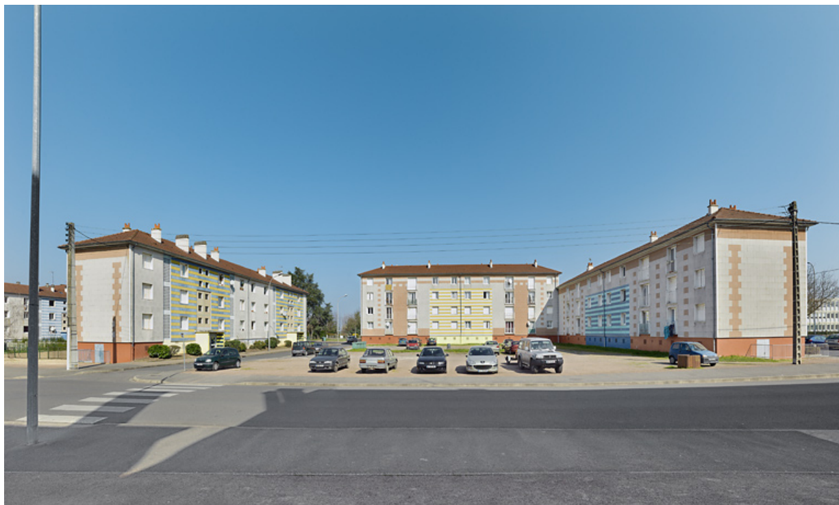
Bâtiments A et B : façades postérieures ; bâtiment C : façade antérieure.
