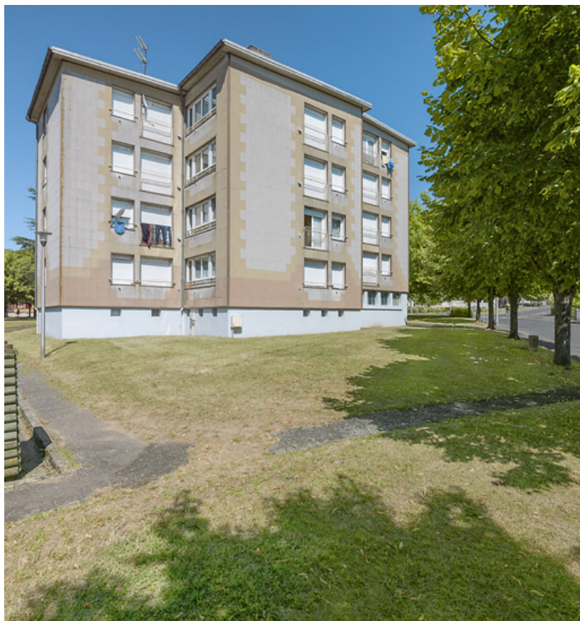
Bâtiment Million-2, façade postérieure sud. 58, Cosne-Cours-sur-Loire rue Fernand Petit
