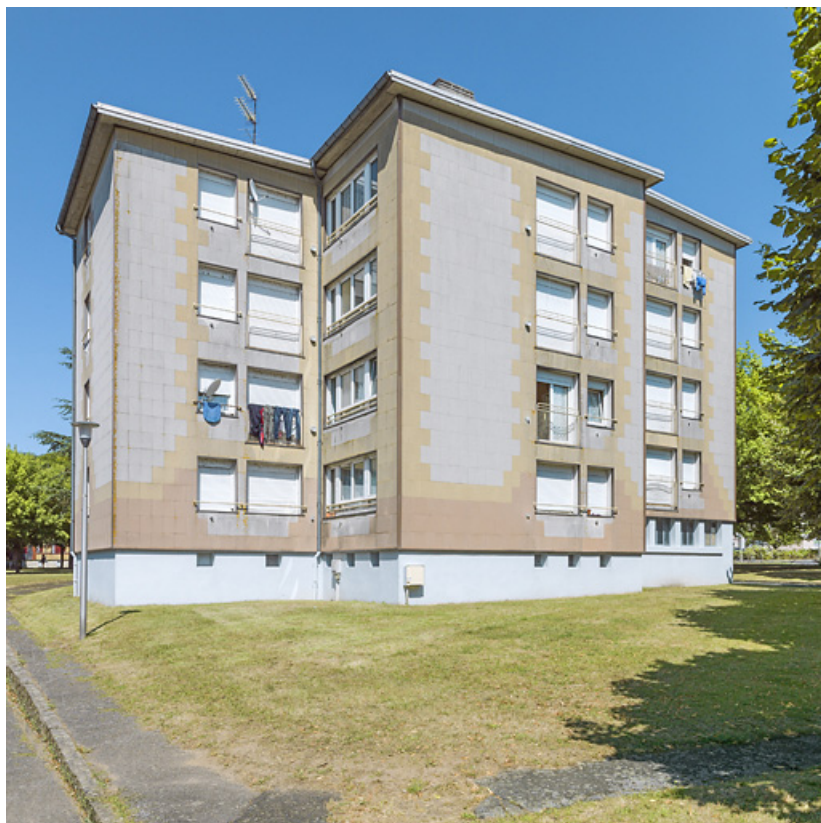
Bâtiment Million-2, façade postérieure sud. 58, Cosne-Cours-sur-Loire rue Fernand Petit
