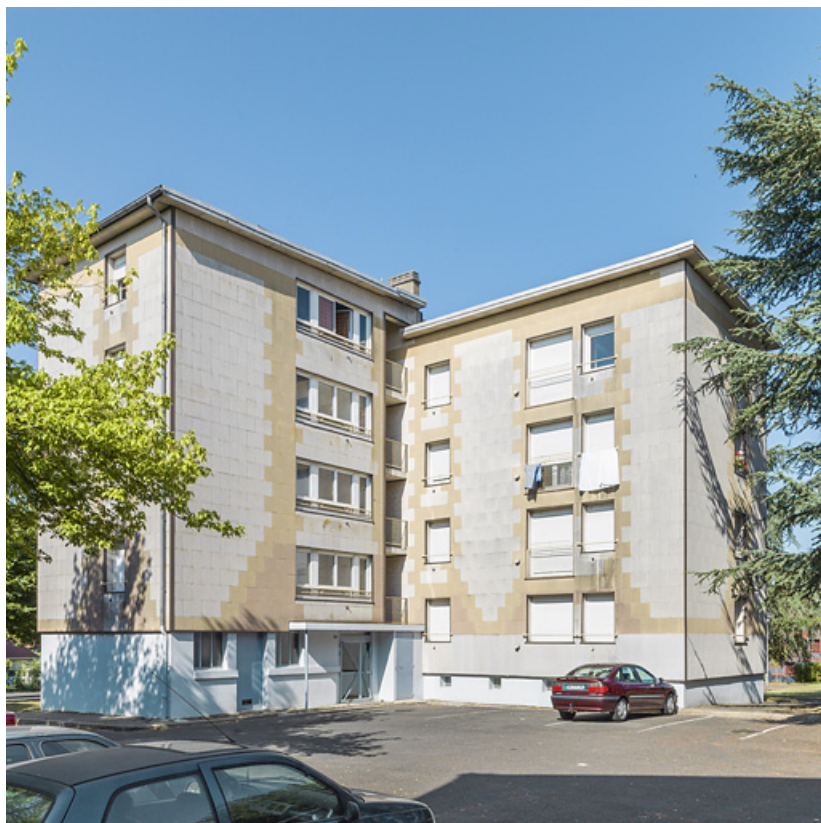
Bâtiment Million-2, façade antérieure nord-est.
