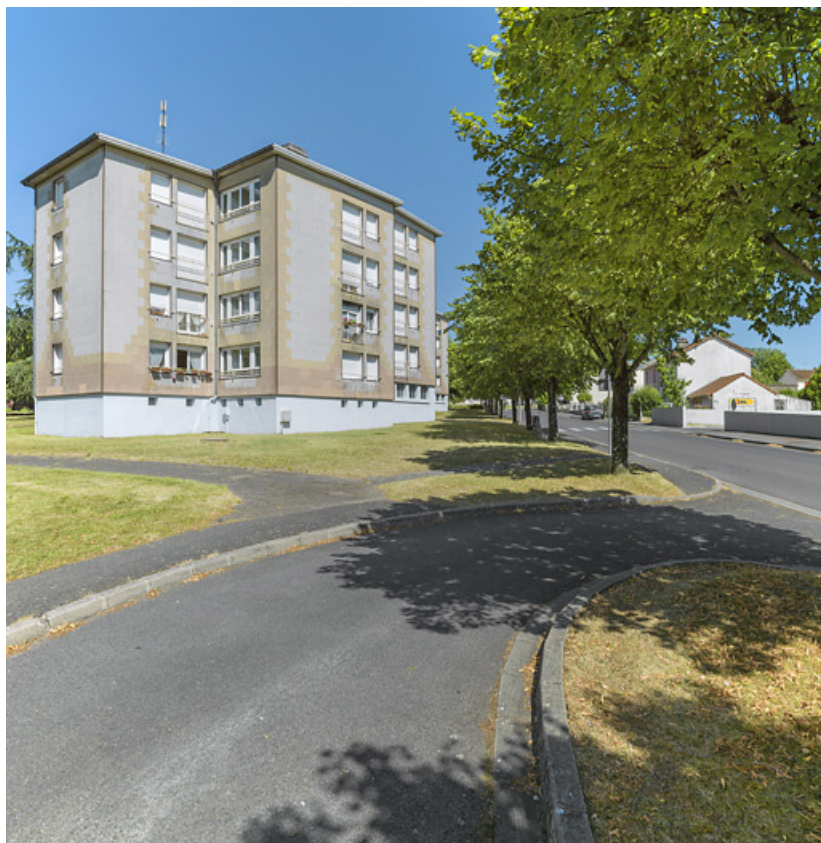
Bâtiment Million-1, façade postérieure sud. 58, Cosne-Cours-sur-Loire rue Fernand Petit
