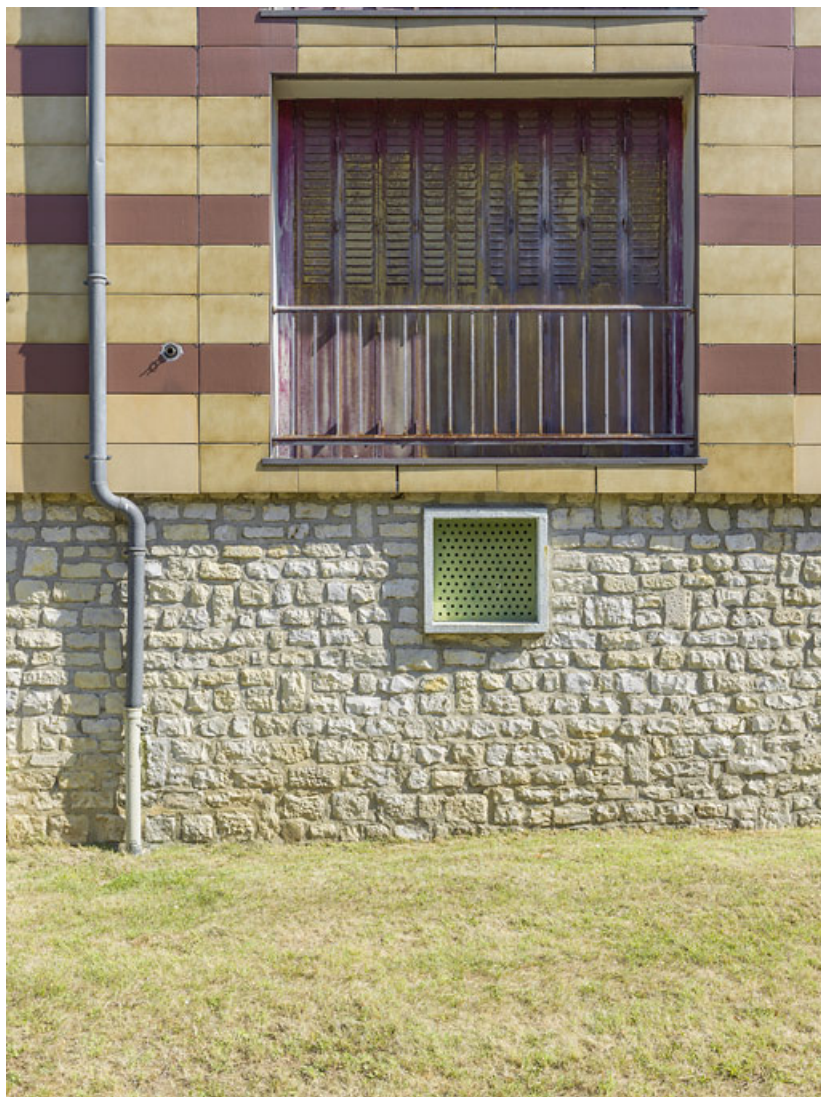
Bâtiment Binot-F, façade postérieure, détail des baies du soubassement et du rez-de-chaussée surélevé. 58, Cosne-Cours-sur-Loire avenue de Verdun
