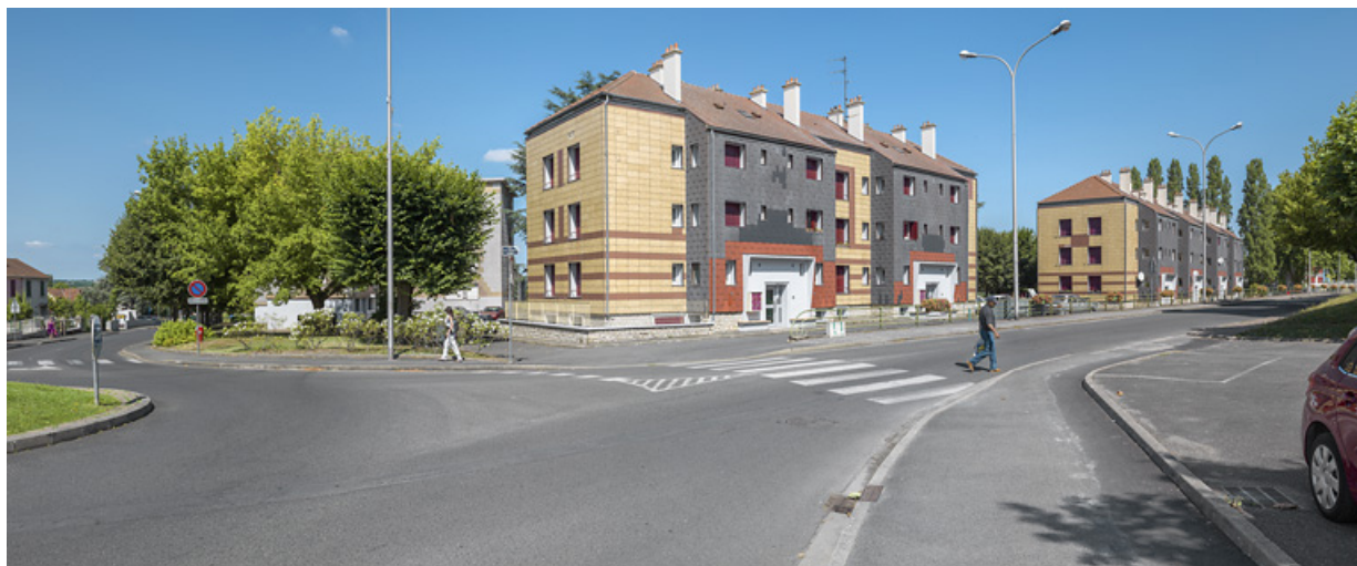
Bâtiments Binot-D et Binot-E, façades antérieures est.
