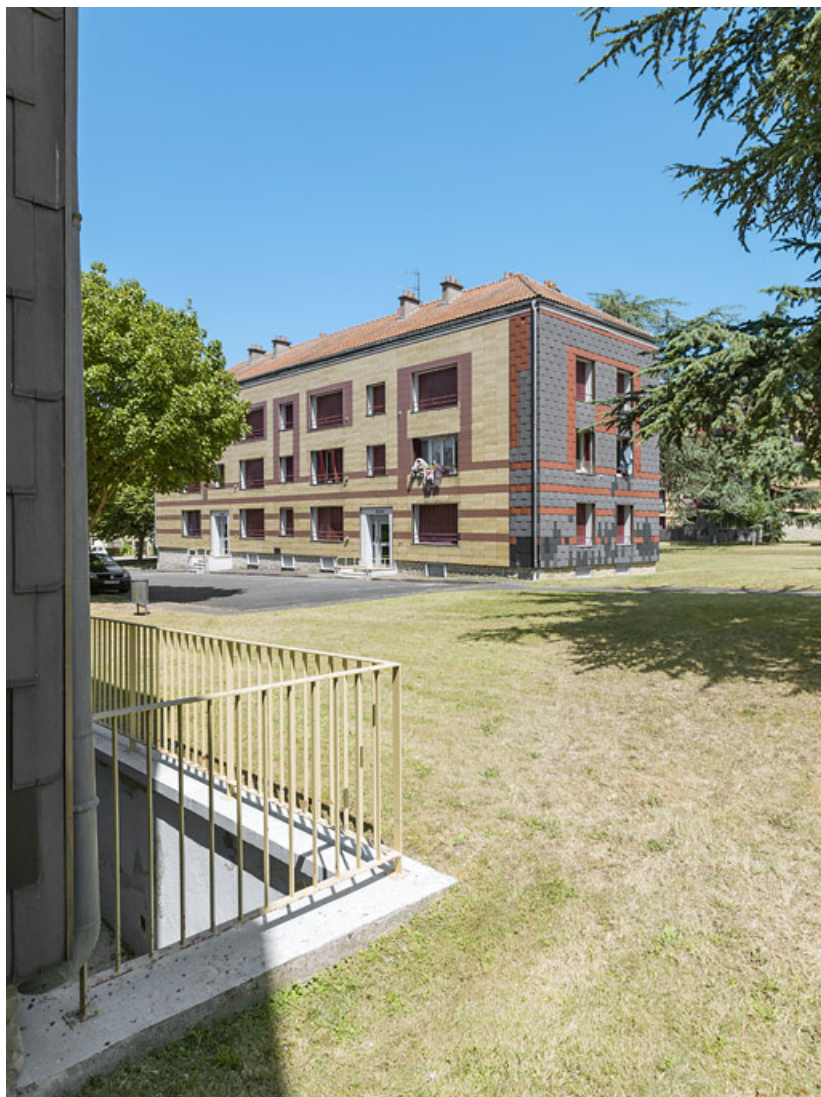
Bâtiment Binot-A, façade antérieure.
