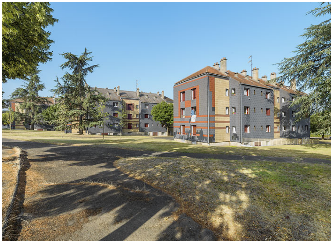
Bâtiments Binot-C, Binot-B et Binot-A, façades postérieures.
