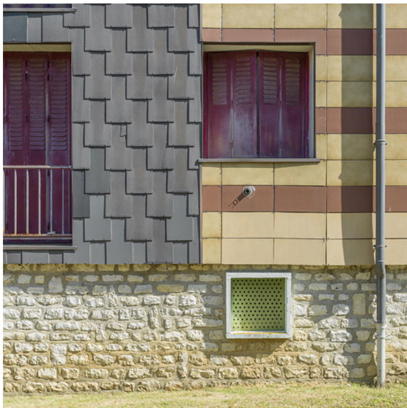
Bâtiment Binot-F, façade postérieure, détail des baies du soubassement et du rez-de-chaussée surélevé. 58, Cosne-Cours-sur-Loire avenue de Verdun
