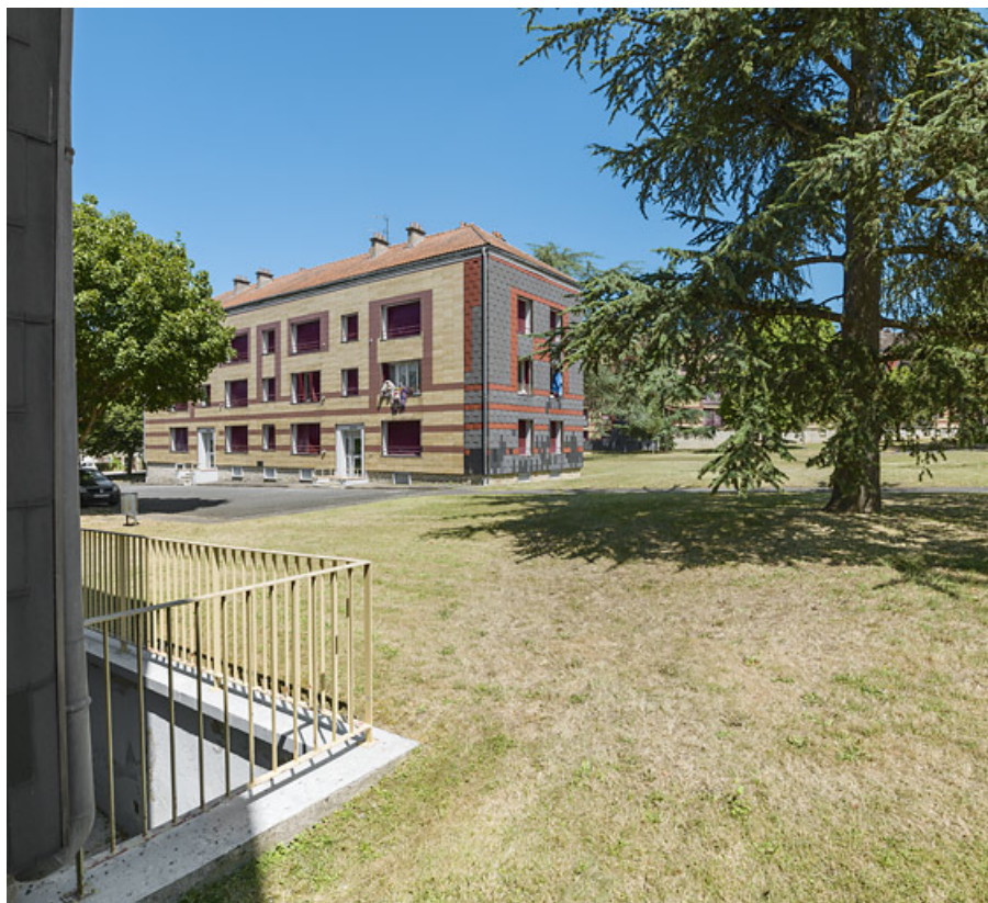
Bâtiment Binot-A, façade antérieure.
