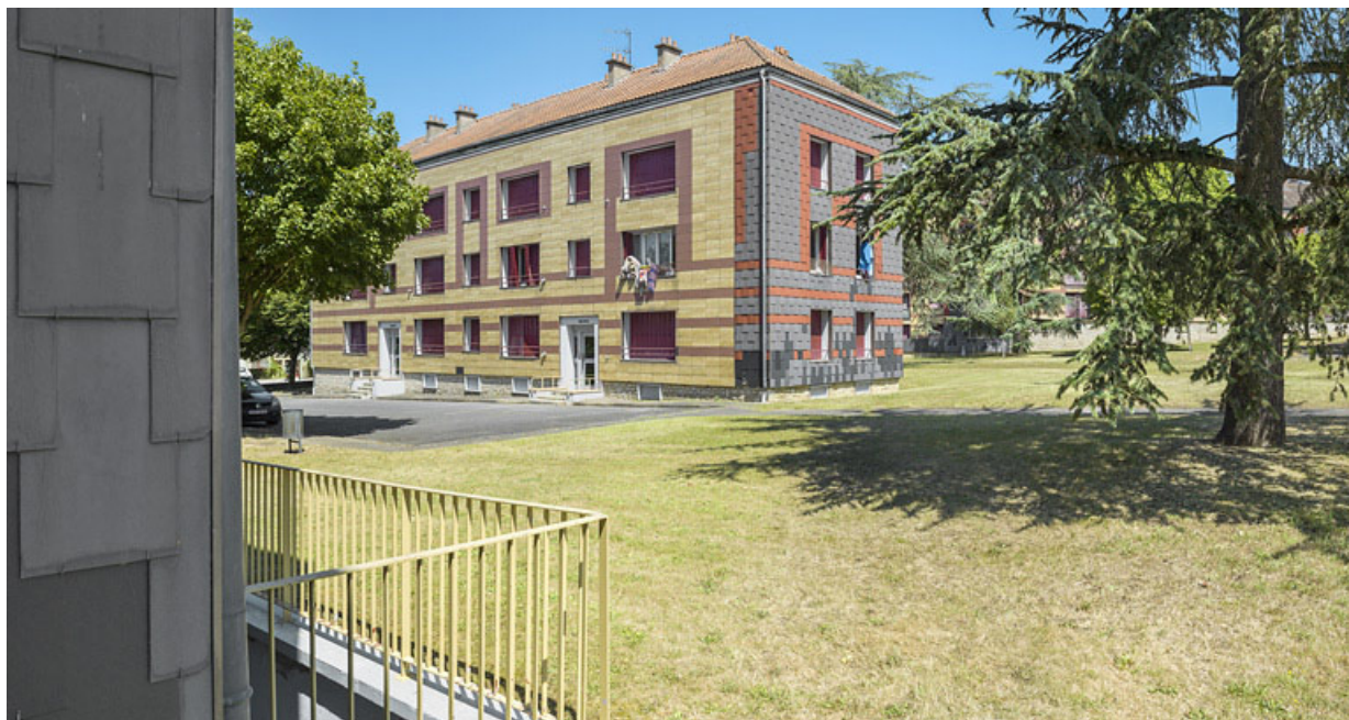
Bâtiment Binot-A, façade antérieure.
