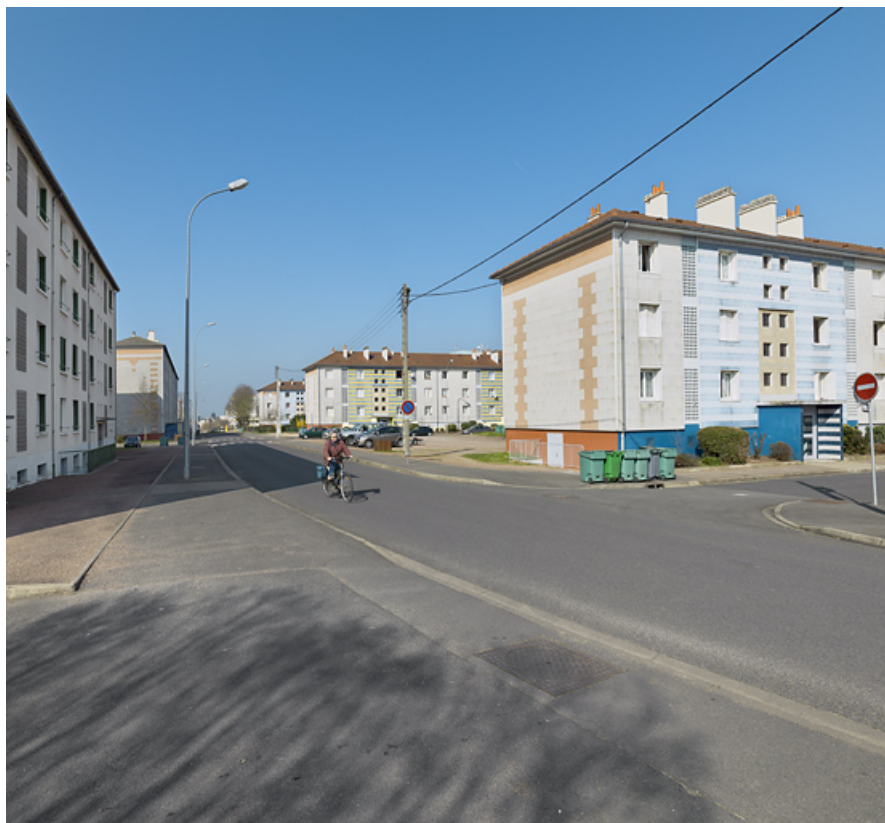
Vue générale depuis le nord de l'avenue de la Paix en direction de l'ouest. 58, Cosne-Cours-sur-Loire avenue de Verdun
