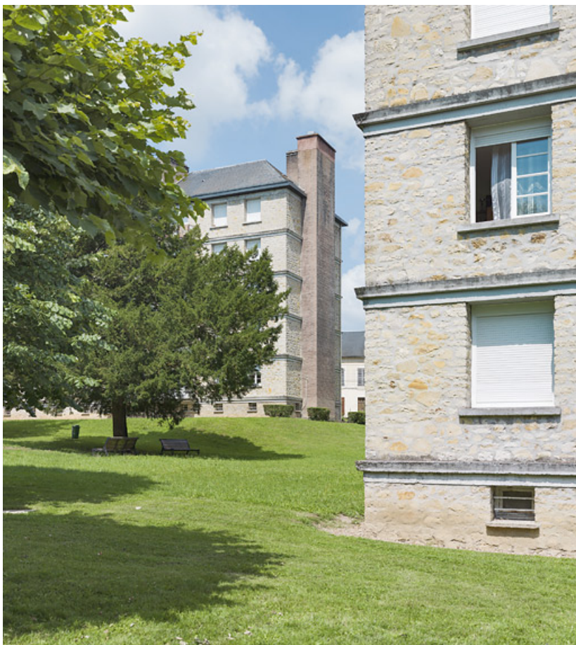
Vue sur la façade postérieure du bâtiment B depuis le bâtiment C. 58, Nevers rue de Gonzague
