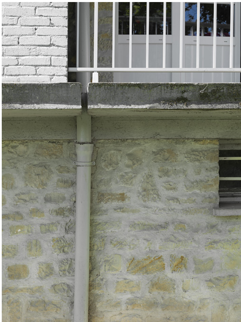
Façade postérieure du bâtiment A : détail du bandeau formant plancher du balcon du rez-de-chaussée. 58, Nevers rue de Gonzague
