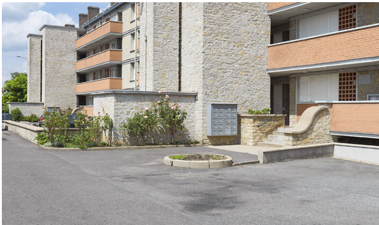
Façade antérieure du bâtiment A : accès aux galeries de desserte des appartements.
