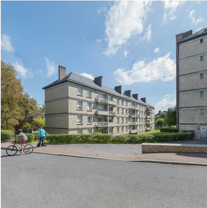
Façade antérieure du bâtiment B et façade postérieure du bâtiment C. 58, Nevers rue de Gonzague
