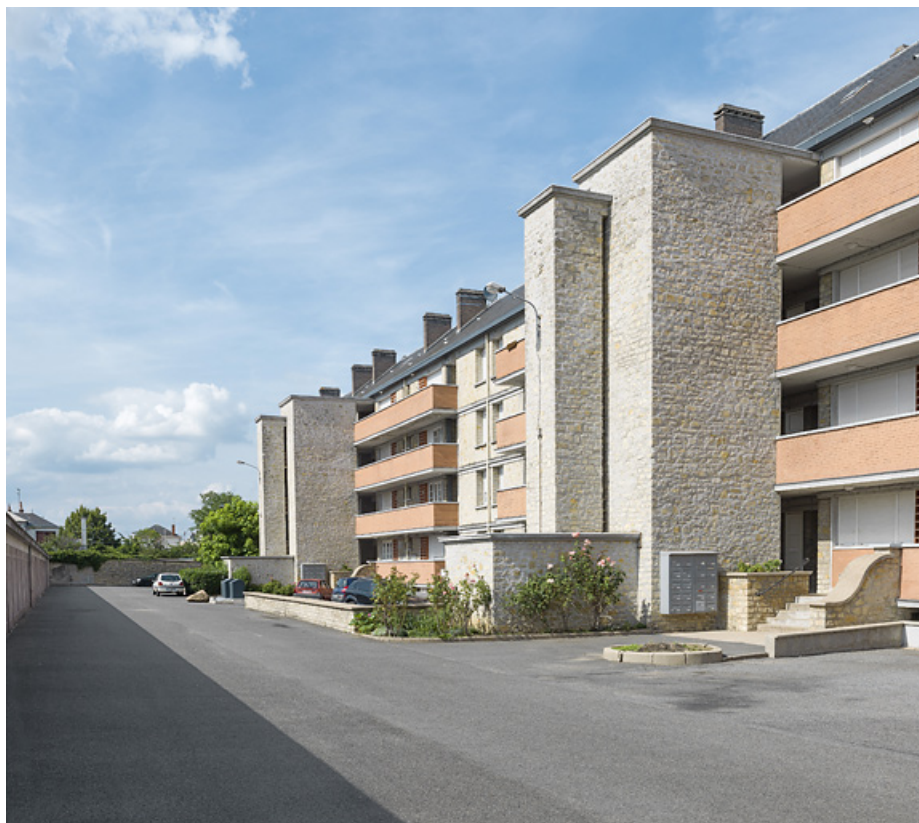
Façade antérieure du bâtiment A.
