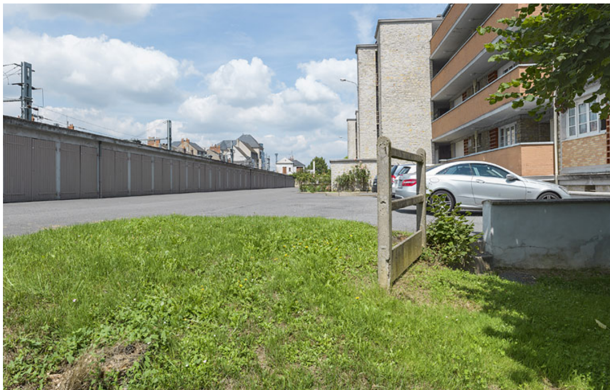
Garages impasse de la Verrerie et façade antérieure du bâtiment A. 58, Nevers rue de Gonzague
