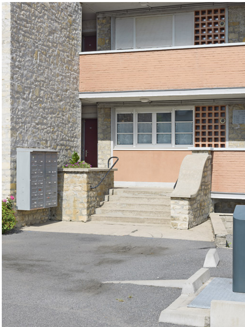
Façade antérieure du bâtiment A : accès aux galeries de desserte des appartements. 58, Nevers rue de Gonzague
