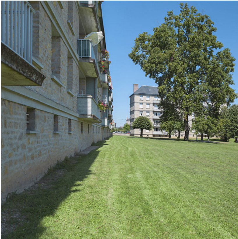
Bâtiments A et B : façades postérieures.
