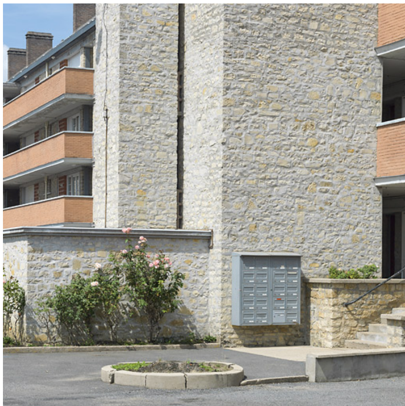
Façade antérieure du bâtiment A.
