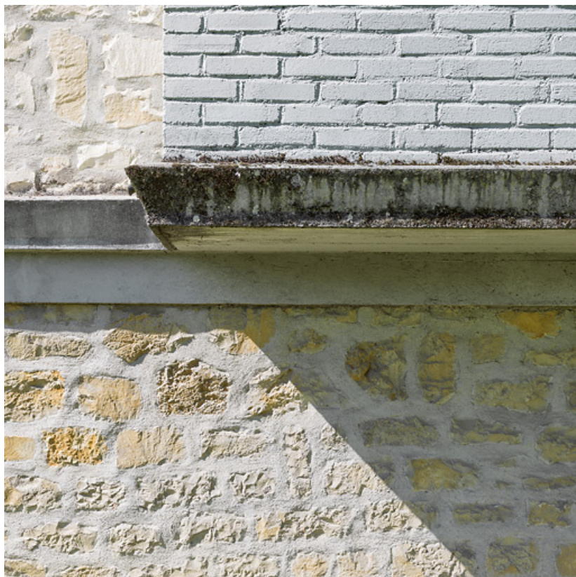
Façade postérieure du bâtiment A : détail du bandeau formant plancher du balcon du rez-de-chaussée. 58, Nevers rue de Gonzague
