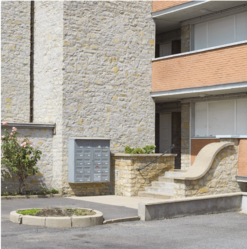
Façade antérieure du bâtiment A : accès aux galeries de desserte des appartements. 58, Nevers rue de Gonzague
