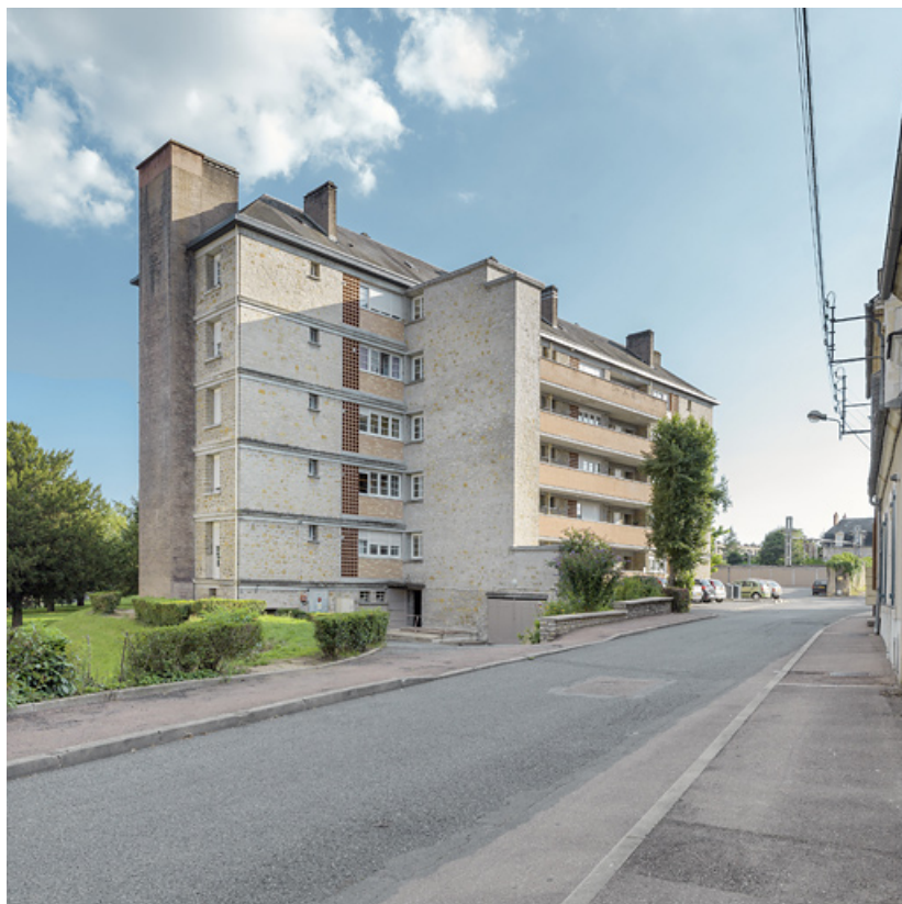
Bâtiment B : façades antérieure et latérale.
