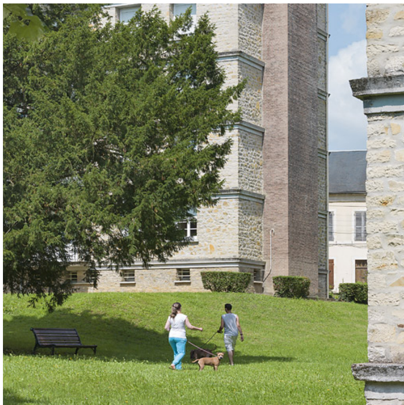
Vue sur la façade postérieure du bâtiment B depuis le bâtiment C. 58, Nevers rue de Gonzague
