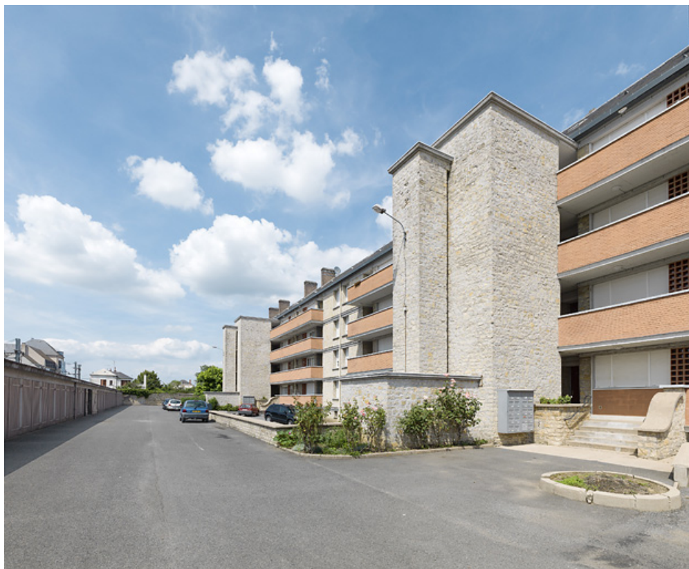
Façade antérieure du bâtiment A.
