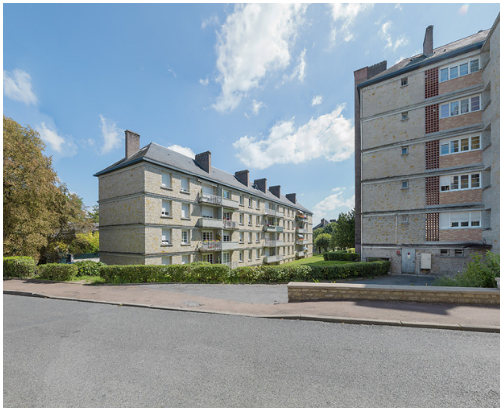
Façade antérieure du bâtiment B et façade postérieure du bâtiment C. 58, Nevers rue de Gonzague
