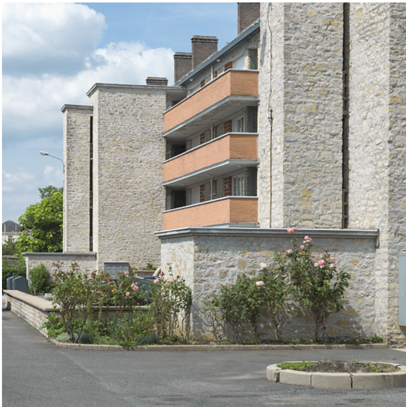
Façade antérieure du bâtiment A.
