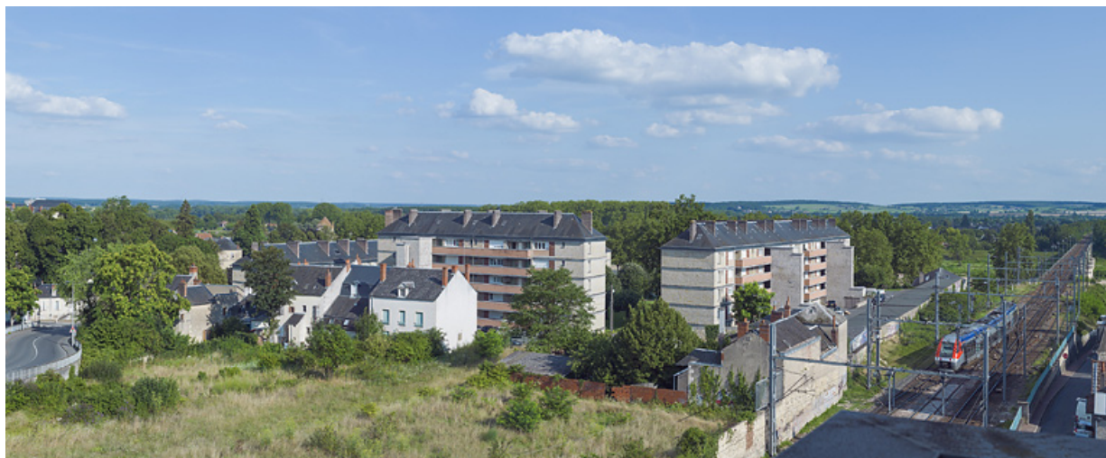
Vue générale depuis le sud-ouest.
