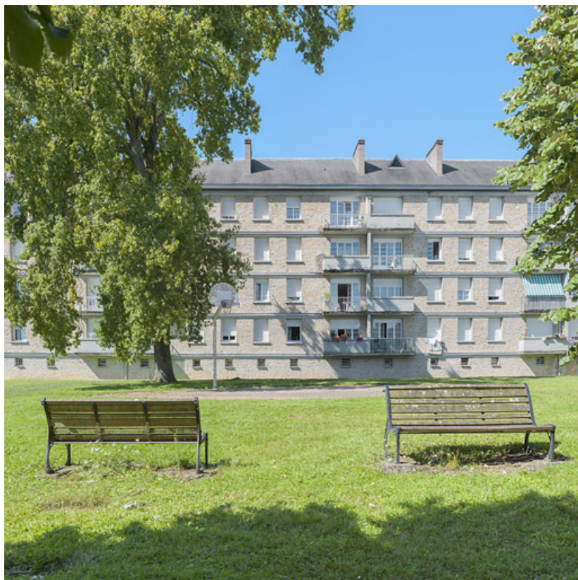
Mobilier urbain et façade postérieure du bâtiment A.
