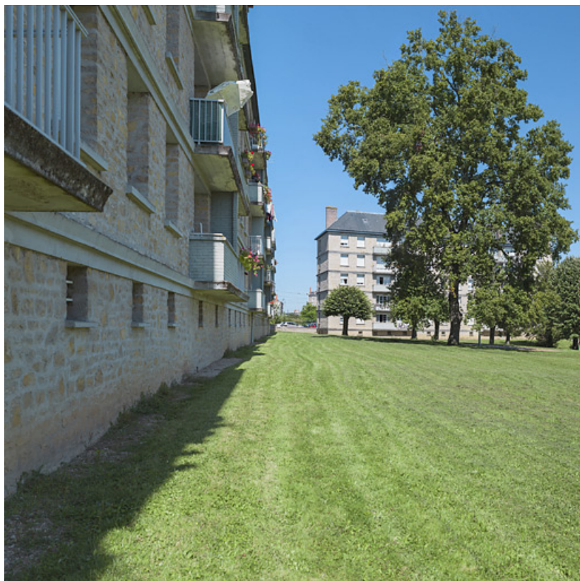
Bâtiments A et B : façades postérieures.
