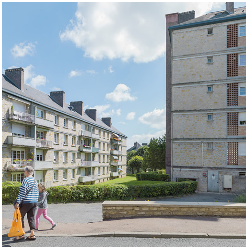
Façade antérieure du bâtiment B et façade postérieure du bâtiment C. 58, Nevers rue de Gonzague
