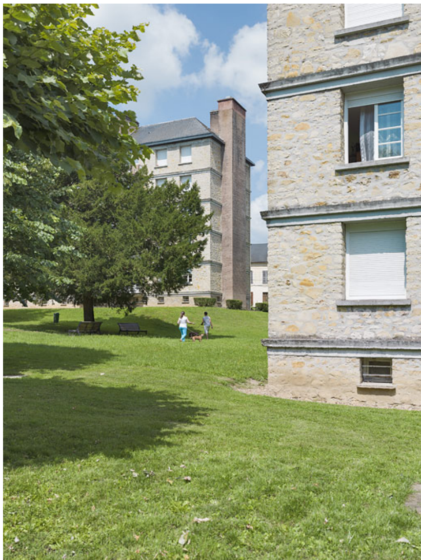
Vue sur la façade postérieure du bâtiment B depuis le bâtiment C. 58, Nevers rue de Gonzague
