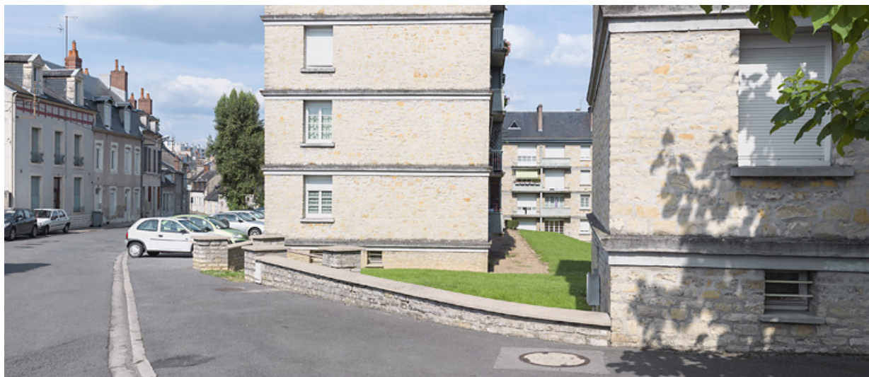
Façade latérale du bâtiment B et vue sur la façade postérieure du bâtiment C. 58, Nevers rue de Gonzague
