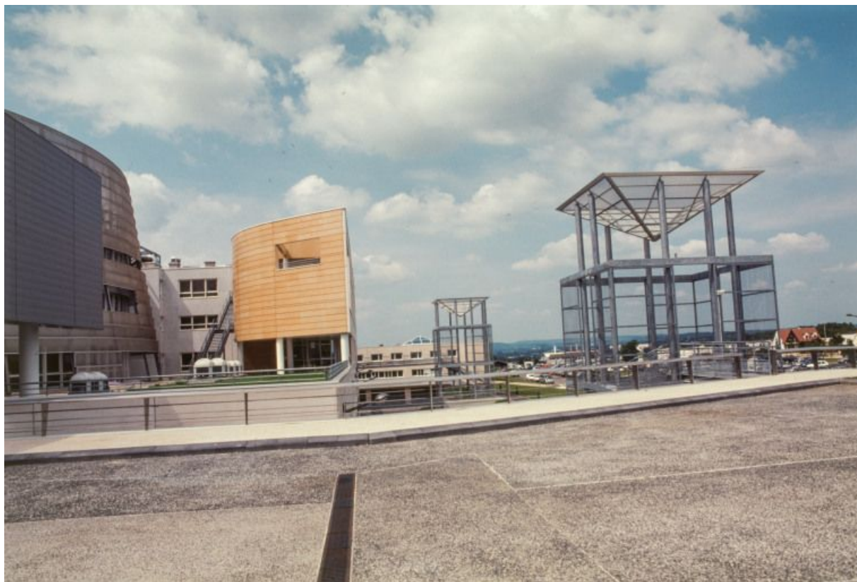
Façade postérieure, vue de la terrasse.
