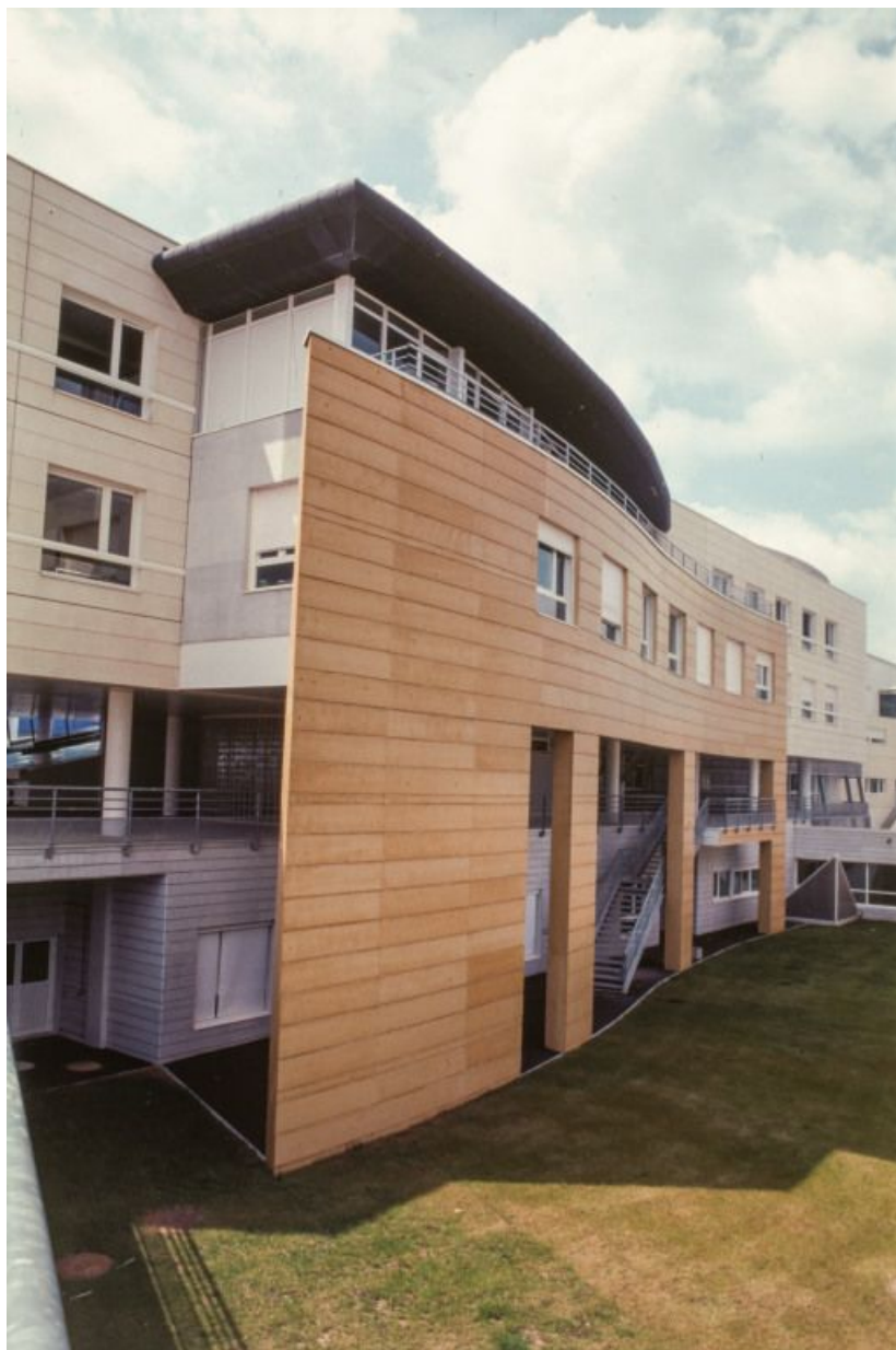
Façade antérieure, détail de la partie gauche.
