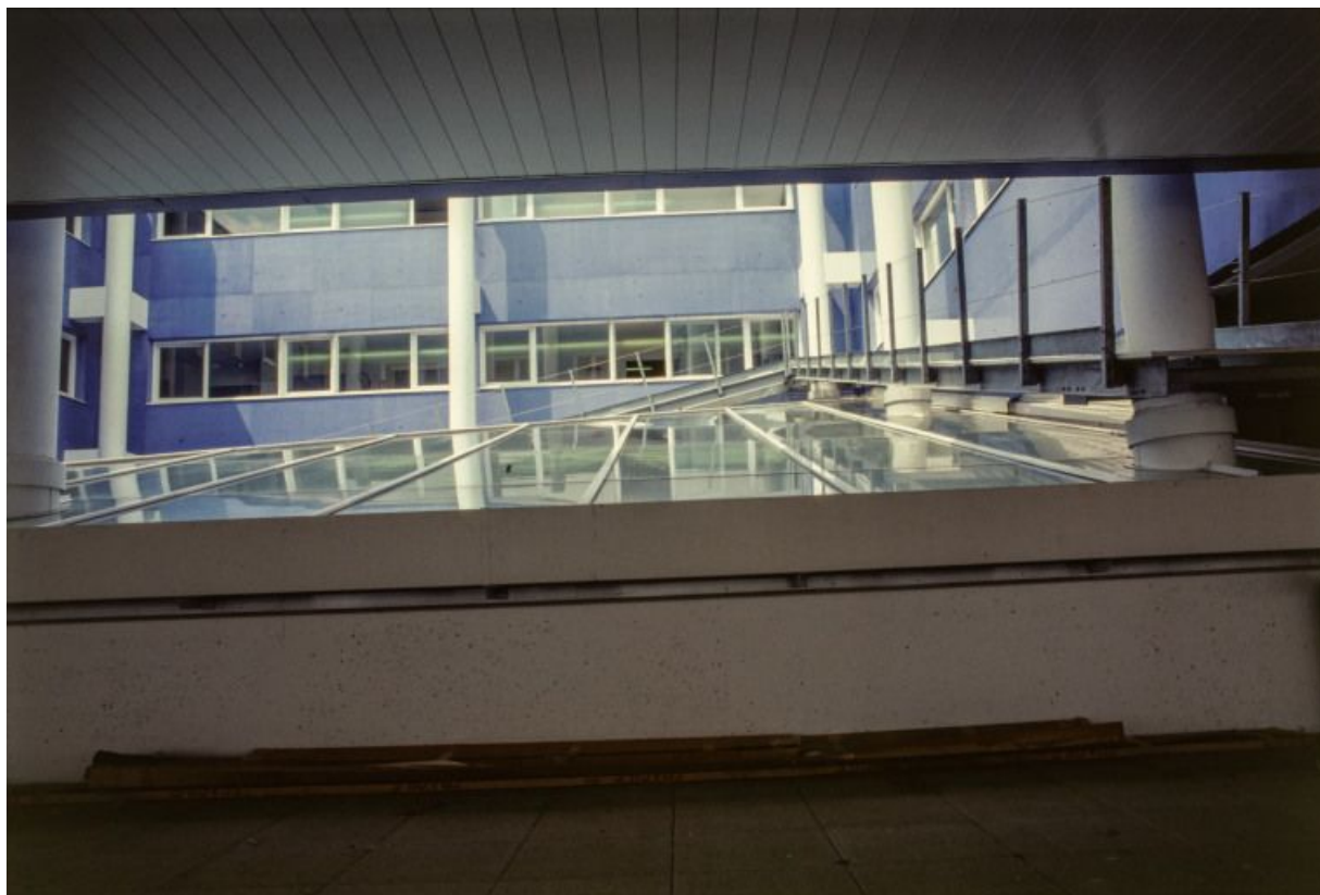
Vue du patio vers les salles d'opération.
