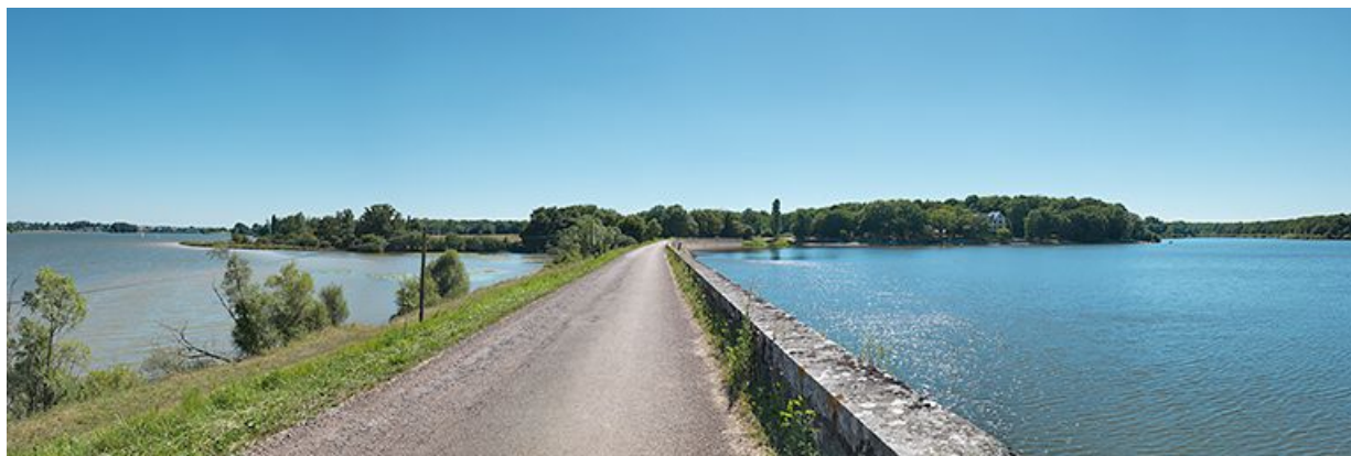
Vue d'ensemble des étangs de Baye et de Vaux depuis la digue les séparant.
