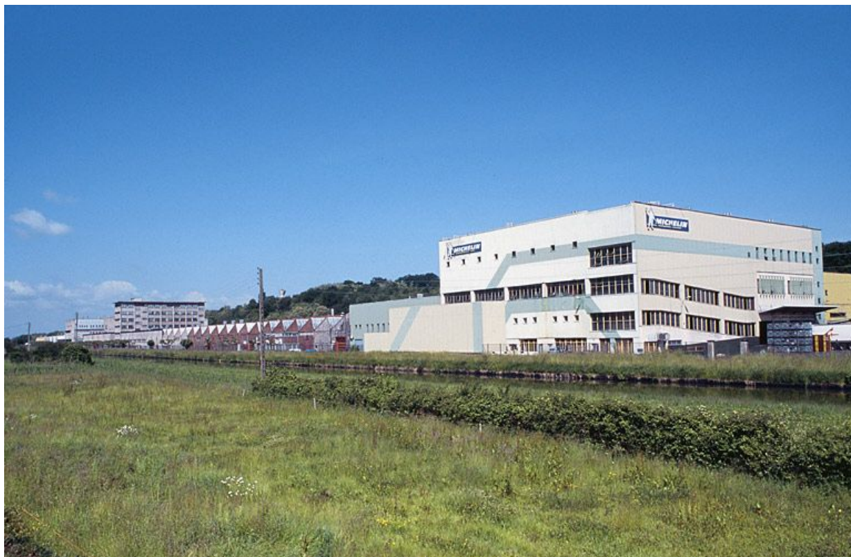
Vue d'ensemble des bâtiments depuis la rive gauche du canal du Nivernais.
