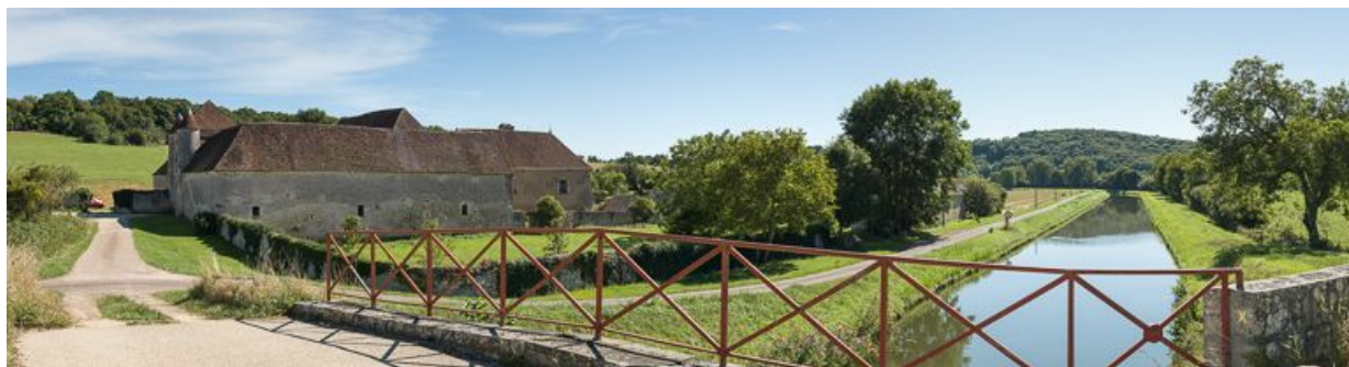
Vue de la chartreuse depuis le pont (IA58000991).
