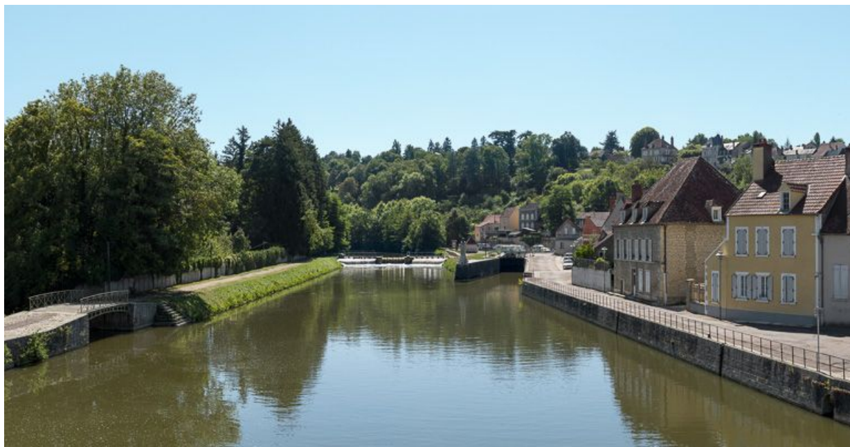
Le site d'écluse et le pertuis dans l'Yonne, vus d'aval. A gauche, passerelle en métal enjambant une prise d'eau dans l'Yonne. 58, Clamecy, lieudit : bief 47 du versant Seine
