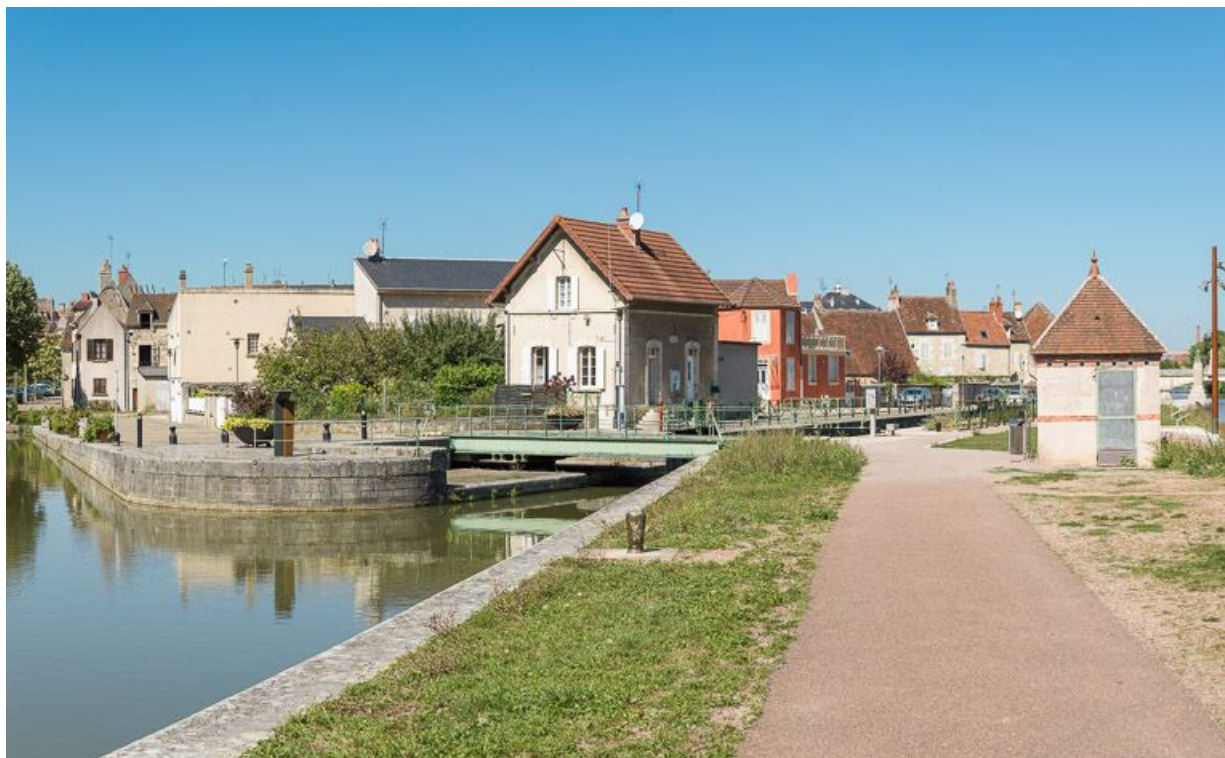
Vue d'ensemble du site, pris d'amont. Au premier plan, le pont mobile (IA58000966). 58, Clamecy, lieudit : bief 47 du versant Seine
