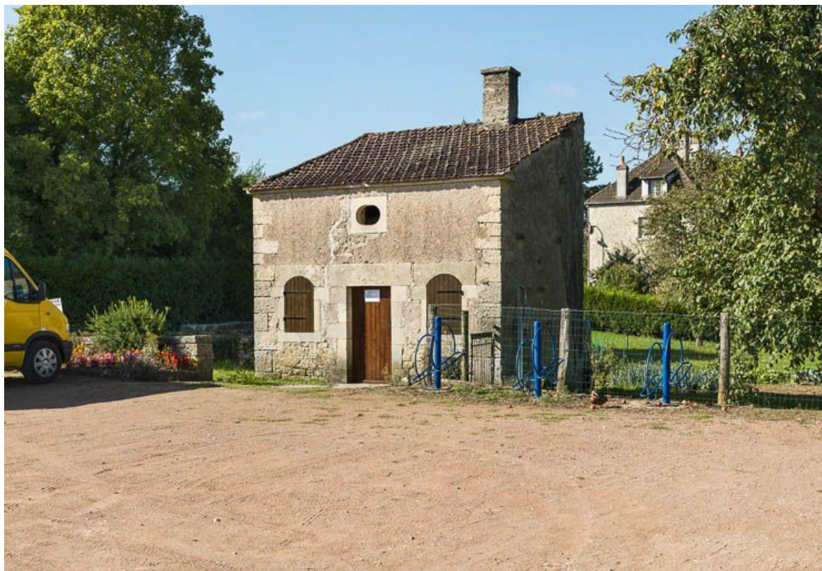
L'abri des ouvriers : vue de 3/4.
