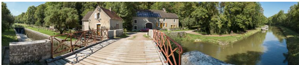
Le pont avec son tablier en bois et ses garde-corps en métal.
