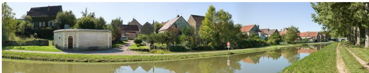
Vue d'ensemble du lavoir, avec l'allée de peupliers sur la rive droite.
