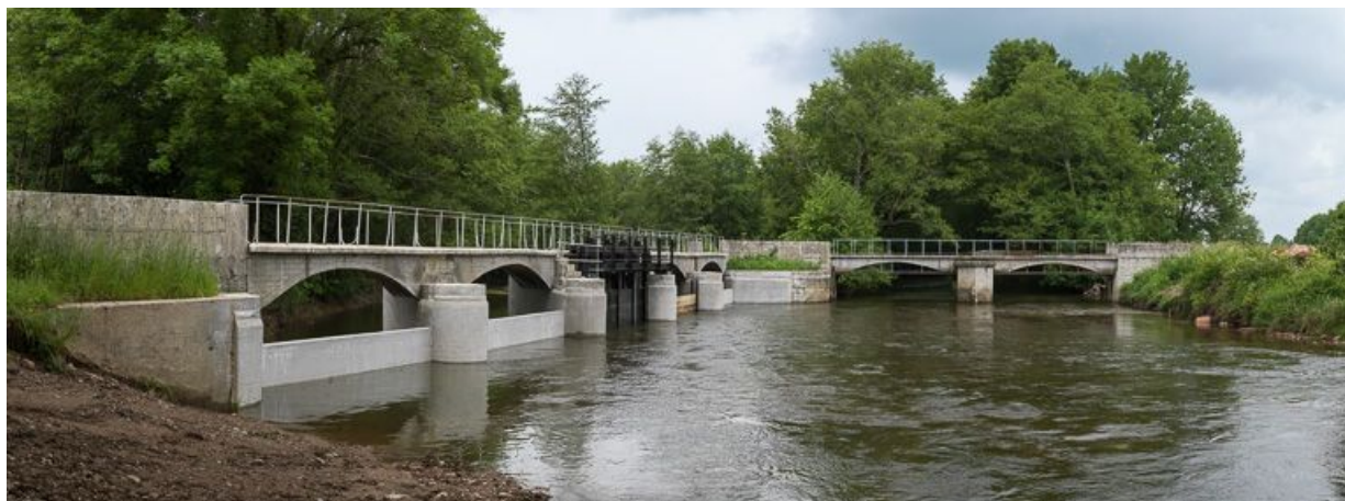
Barrage de prise d'eau sur l'Yonne.
