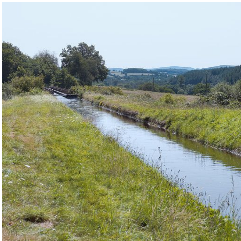
La rigole d'Yonne à Oussy. On aperçoit l'aqueduc.
