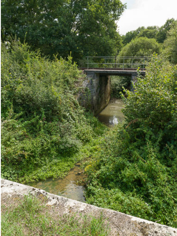
Vue de l'aqueduc, au premier plan, et du ruisseau.
