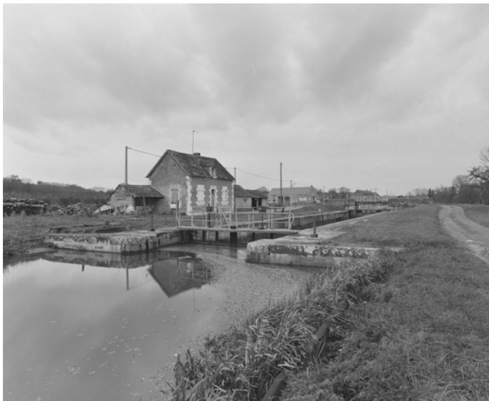
L'écluse n°33, dite de Mont : vue d'ensemble prise de l'amont. 58, Dirol
