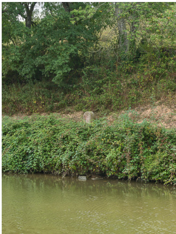
Borne en aval du site d'écluse, sur la rive gauche.
