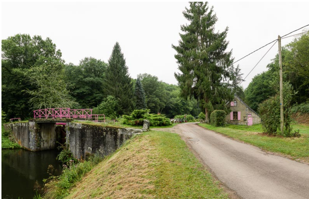
Vue d'ensemble du déversoir de superficie, de la maison éclusière et du chemin de halage.
